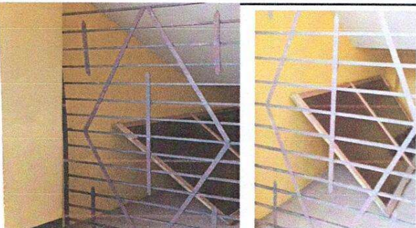
sustitución de puesta metalica y muro
