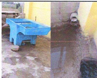
instalacion de pila de concreto y reparación de drenaje
