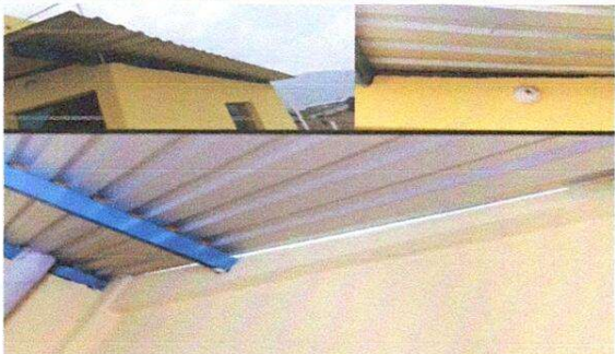
Reparación de muro para cierre de espacio entre y techo. sustitución de cielo falso de tablayeso. sustitución de lampara por lampara led empotrables
