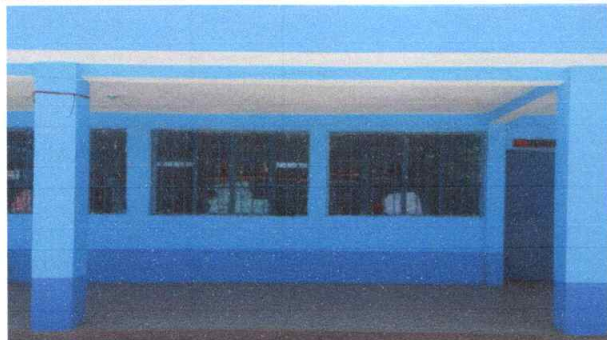
Suministro y aplicación de pintura latex, para exterior y zócalo
