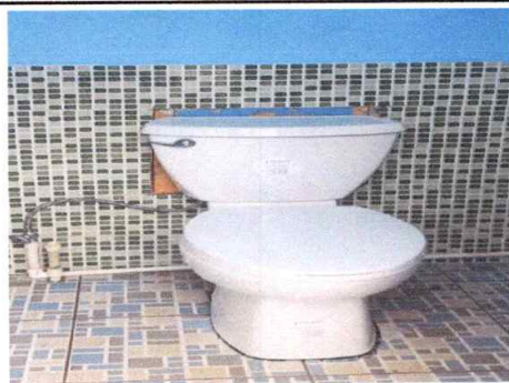
Sustitución de inodoros elongado en baños
