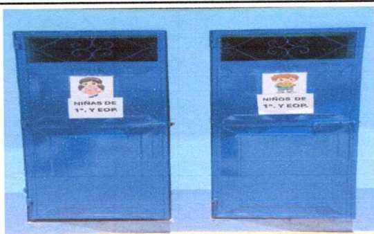
Sustitución de puertas de metal en baños
