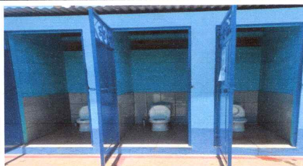
Servicio y suministro de tazas e instalación de red de agua
