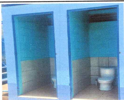
Sustitución de puertas de metal en baños
