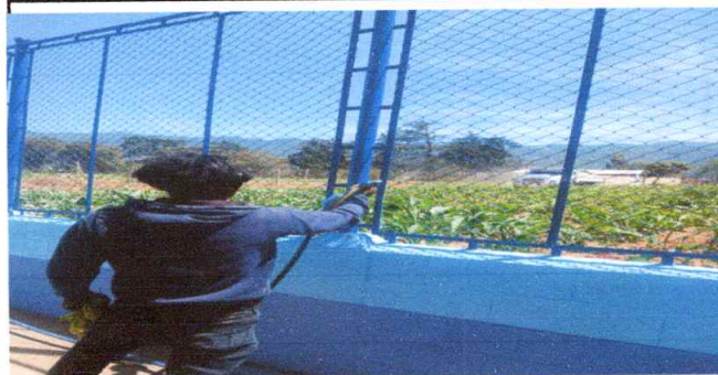
Mantenimiento de rejas perimetrales en muro de circulación
