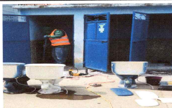
Servicio y suministro de tazas e instalación de red de agua
