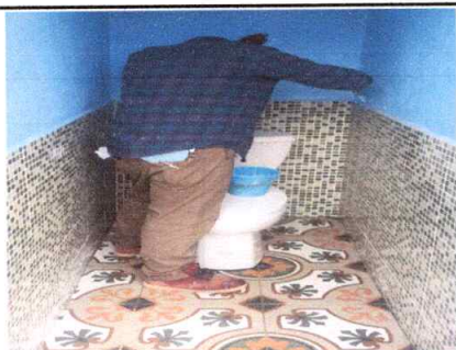
Sustitución de inodoros elongado en baños
