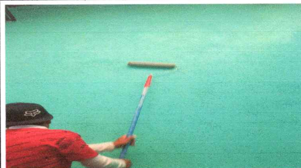
suministro y aplicación de pintura latex para interior
