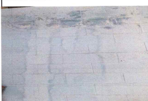
Suministro y aplicación de pintura latex para interior
