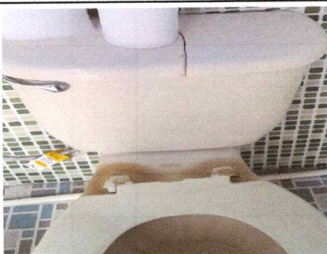
Sustitución de inodoros elogando en baños
