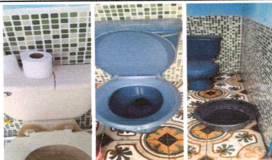
Servicio y suministro de tazas e instalación de rede de agua
