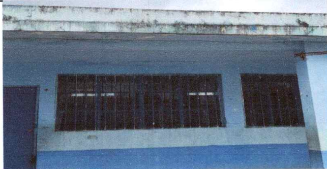
Suministro y aplicación de pintura latex, para exterior y zócalo
