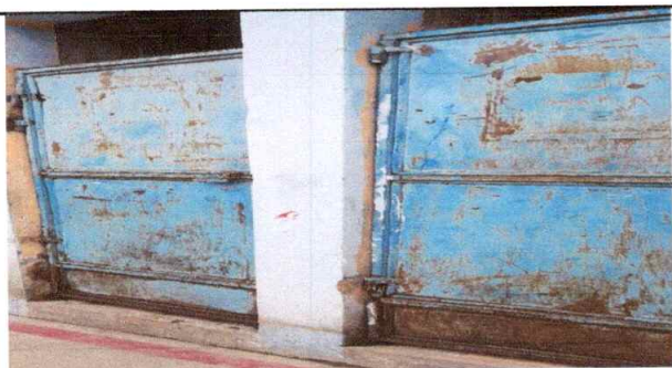
Sustitución de puertas de metal en baños
