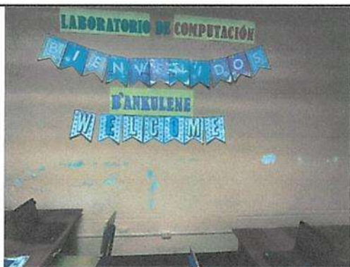
Suministro y aplicación de pintura interior Satinado blue Mosque en aula 10 Modulo 4
