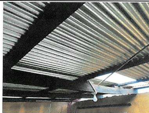
Sustitución de estructura de soporte de madera por metal en cocina.
