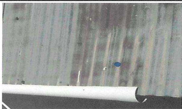
Sustitución de tubo pvc 4 pulgadas (bajadas de agua) en cocina.
