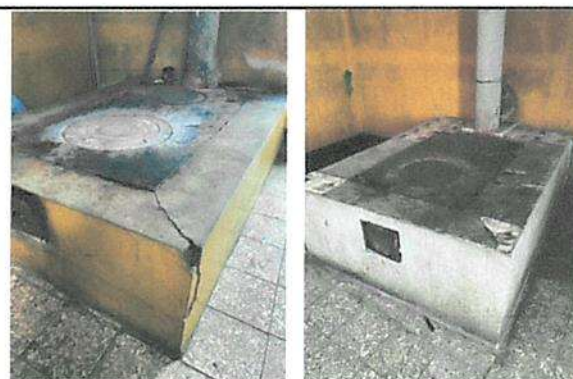
Sustitución de estufas rural en cocina con ladrillo y chimenea en cocina.
