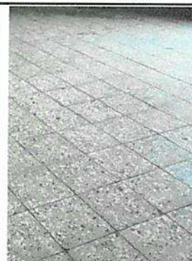
Sustitución de piso mosaico por piso cerámica en cocina.
