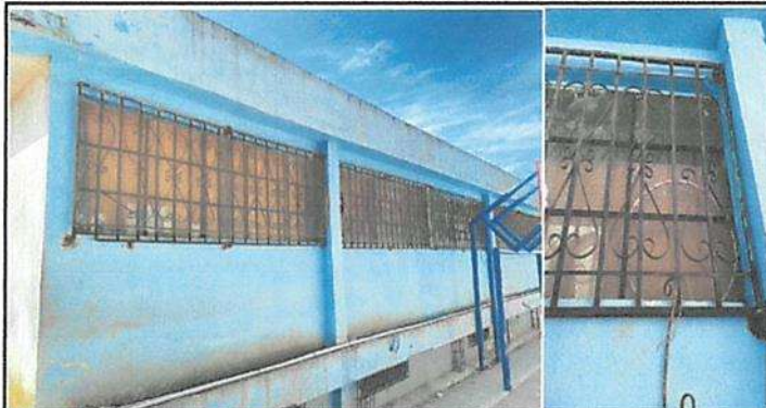
Mantenimiento de balcones en exterior (lijado, pintado y cambio de partes de perfiles dañados) en Modulo 4.
