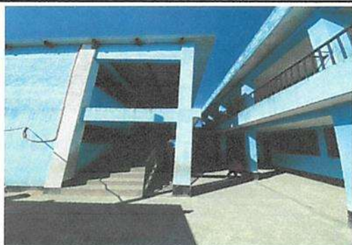
Suministro y aplicación de pintura interior Colonial Style mate verde en pasillos en Modulos 1, 3 y 4.
