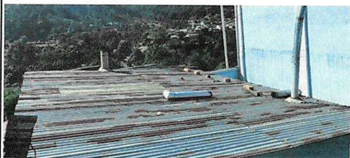
Sustitución de lamina, por lamina troquelada aluzinc calibre 26 en cocina.
