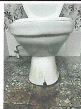
Sustitución de inodoro enlogado en baños.
