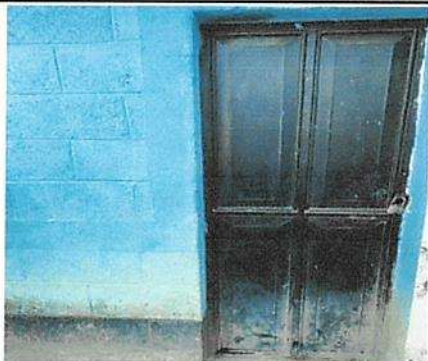
Sustitución de puerta de metal en cocina.
