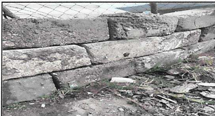
Sustitución de pared por Muro perimetral
