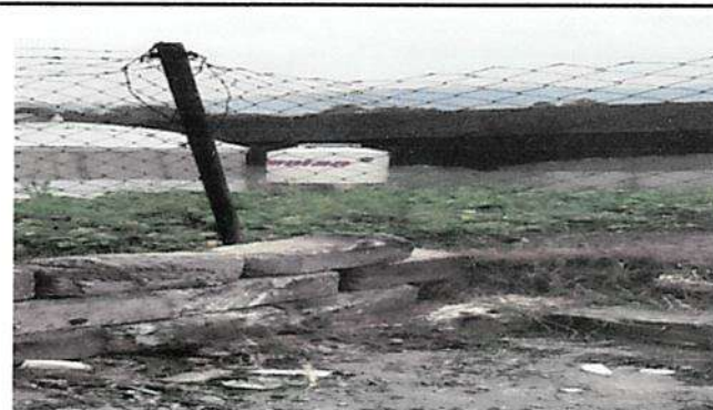
Sustitución de maya por Muro Perimetral
