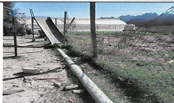
Sustitución de maya por Muro perimetral
