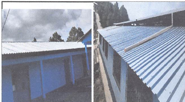
Sustitución de lámina por lámina Troquelada 0.38 Calibre 26" módulo 1 y 2. 310 m2
