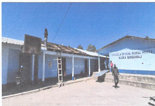
Mantenimiento y aplicación de pintura de aceite corona color celeste para muros exteriores e interiores de aulas módulo 1. 361.25 m2
