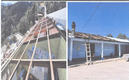
Sustitución de lámina por lámina Troquelada 0.38 Calibre 26" módulo 1 y 2. 310 m2
