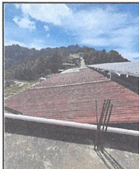
Sustitución de lámina por lámina Troquelada 0.38 Calibre 26" módulo 1 y 2. 310 m2
