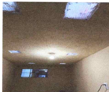
Mantenimiento correctivo con de repello y cernido de muros en dirección módulo 2
