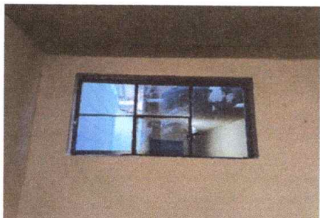
Sustitución de ventana en dirección módulo 2
