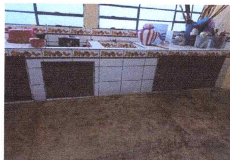
Sustitución de puertas metálicas en gabinete de cocina por puertas de metal módulo 2
