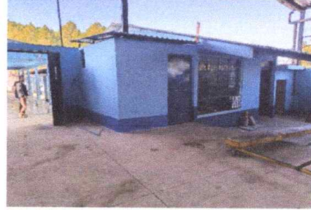
Sustitución techo de lamina por lamina en área de molino módulo 2
