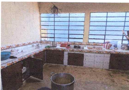
Sustitución de Azulejo por Azulejo en cocina módulo 2
