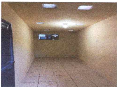
Mantenimiento correctivo con repello y cernido de losa en dirección módulo 2
