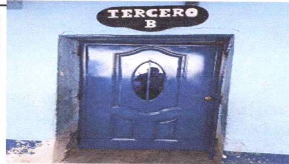
Sustitución de puertas en aulas módulo 1
