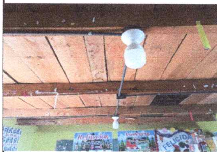
Reparación de cableado eléctrico CALIBRE 12 AWG (sobrepuesto) aulas, dirección y pasillo módulo 1,2,3
