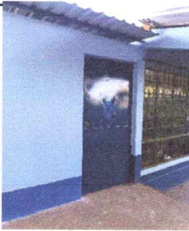
Sustitución estructura de madera por estructura de metal en área de molino módulo 2
