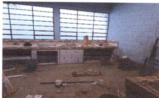
Sustitución de puertas metálicas en gabinete de cocina por puertas de metal módulo 2
