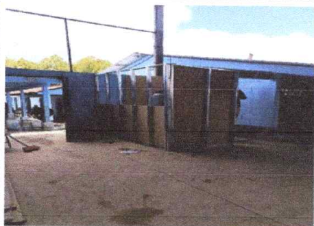
Sustitución muro de lamina y madera por muro de durock (incluye puerta y ventana existente en muro) módulo 2.
