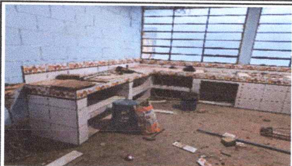
Sustitución de Azulejo por Azulejo en cocina módulo 2
