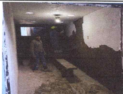
Mantenimiento correctivo con de repello y cernido de muros en dirección módulo 2
