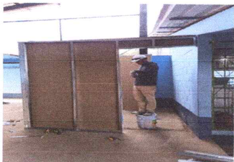
Sustitución estructura de madera por estructura de metal en área de molino módulo 2
