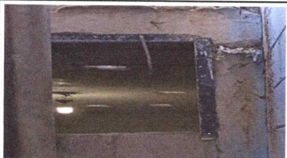
Sustitución de ventana en dirección módulo 2
