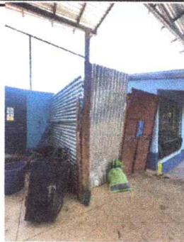
Sustitución techo de lamina por lamina en área de molino módulo 2
