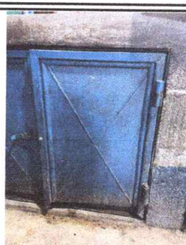
Sustitución de puertas metálicas en gabinete de cocina por puertas de metal módulo 2
