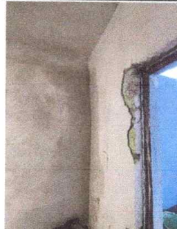
Mantenimiento correctivo con de repello y cernido de muros en dirección módulo 2
