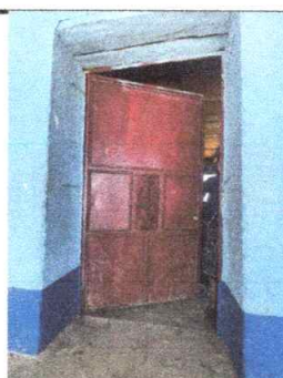
Sustitución de puertas en aulas módulo 1
