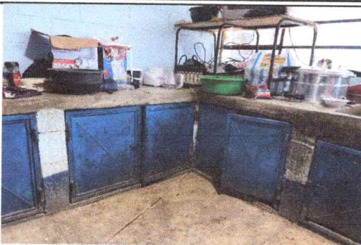
Sustitución de Azulejo por Azulejo en cocina módulo 2
