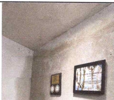
Mantenimiento correctivo con repello y cernido de losa en dirección módulo 2
