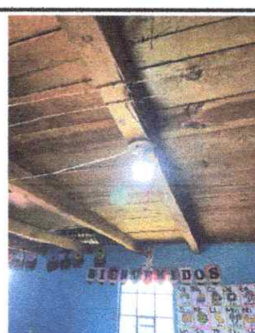
Reparación de cableado eléctrico CALIBRE 12 AWG (sobrepuesto) aulas, dirección y pasillo módulo 1,2,3
