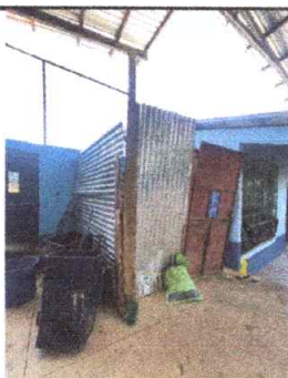
Sustitución estructura de madera por estructura de metal en área de molino módulo 2
