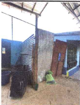
Sustitución muro de lamina y madera por muro de durock (incluye puerta y ventana existente en muro) módulo 2.
