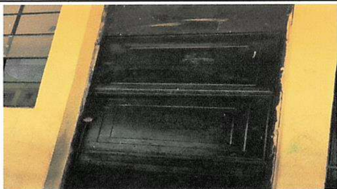
Mantenimiento a Estructura de Puertas (lijado, cambio de tubo, cepillado, sujeciones, aplicación de pintura) en Aulas y Cocina Modulo 1 y 2
