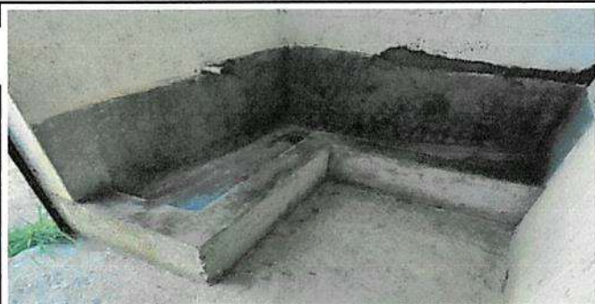
Sumistro y Aplicación de Azulejo en Cocina, Migitorios y Lavamanos
