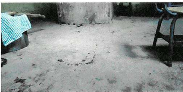
Sustitucion de Torta de Concreto por Piso Granito, en Cocina
