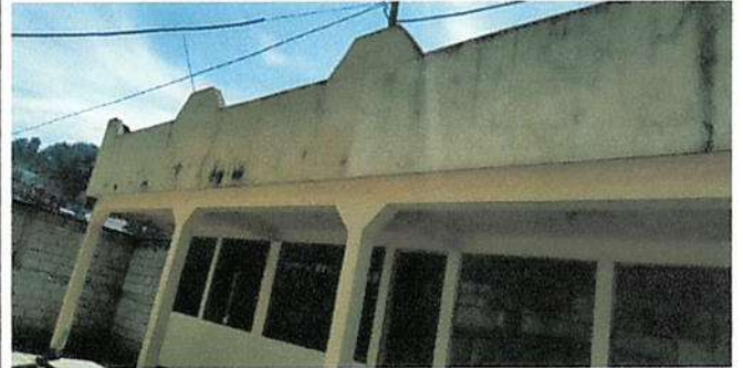
Suministro y Aplicación de Pintura Exterior Latex En Muros y Aulas Modulo 1 y 2
