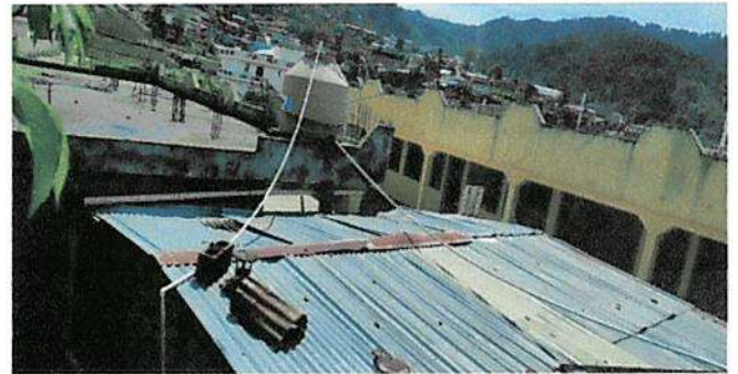
Sustitucion de Lamina por Lamina Troquelada Calibre 26, en Cocina y Baños
