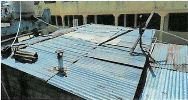
Sustitucion de Lamina por Lamina Troquelada Calibre 26, en Cocina y Baños
