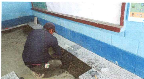
Foto1: Sustitucion de piso de concreto a piso granito en cocina, 2 aulas y pasillo
