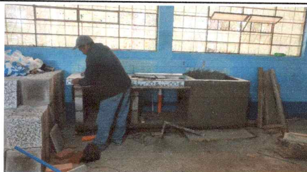
Foto 4: Sustitucion de pila de concreto por lavatrastos de concreto reforzado con azulejo en cocina
