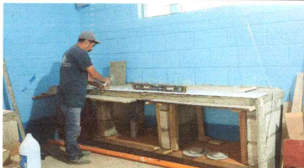
Foto 5: Mantenimiento correctivo de mesa de trabajo por meson de concreto incluye (azulejo, gabinetes y puertas de metal) en cocina.
