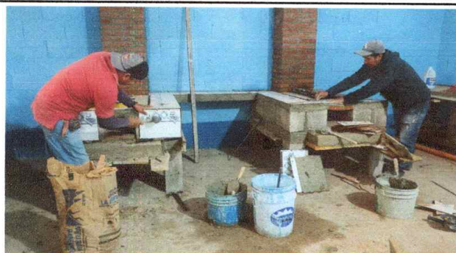
Foto 3: Sustitucion de plancha completa incluye chimenea de ladrillo y plancha de metal en cocina
