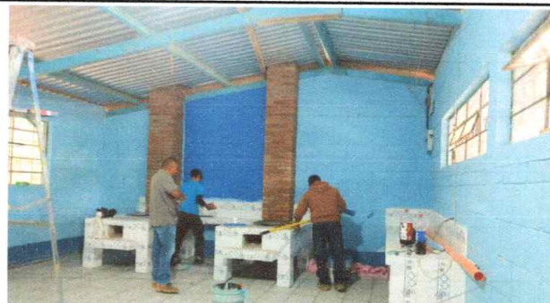
Foto 6: Mantenimiento de muros con suministro y aplicación de pintura latex en interior de muros de cocina.
