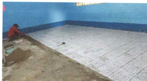
Foto 2: Sustitucion de piso de concreto a piso granito en cocina, 2 aulas y pasillo
