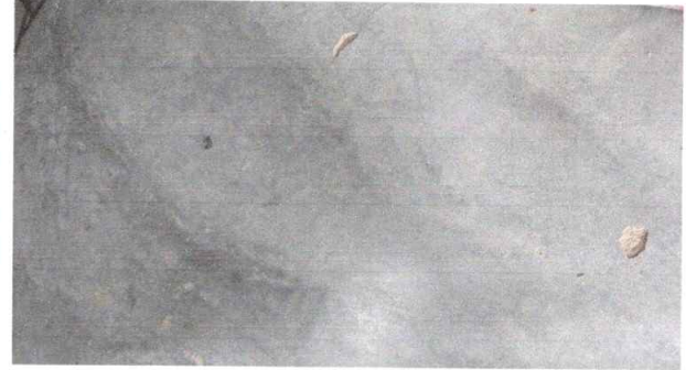
Sustitución de piso de concreto a piso granito en cocina, 2 aulas y pasillo
