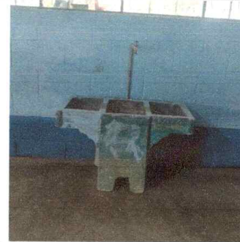
Sustitucion de pila de concreto por lavatrastos de concreto reforzado con azulejo en cocina
