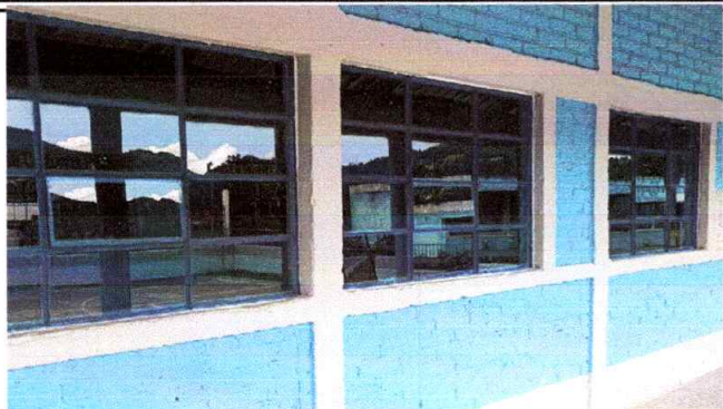
Sustitución de ventanas de madera por ventana marco de metal con Tee de 3/4 legítimo
