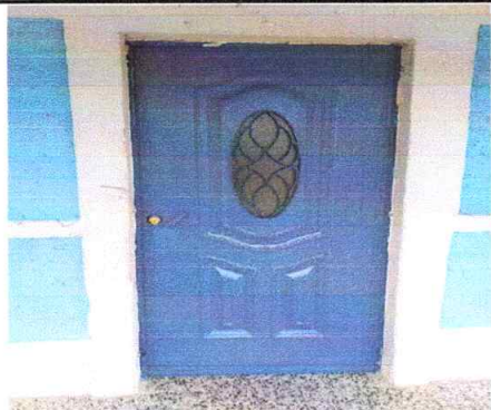
Sustitución de puertas de madera por puertas de metal con lámina 364 chapa Yale
