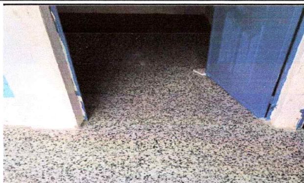
Sustitución de piso de concreto por piso granito en aulas y corredor en modulo 1
