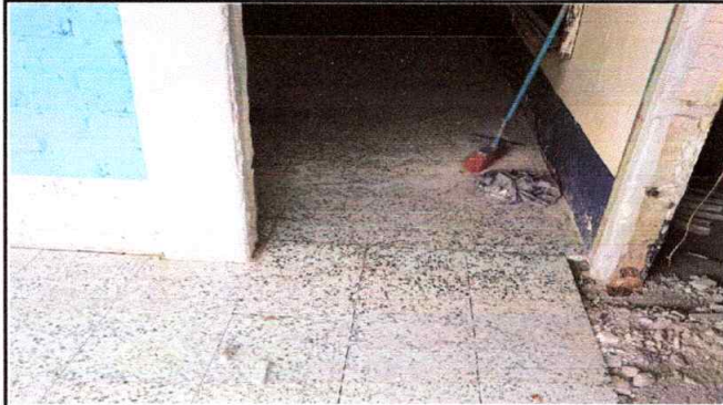
Sustitución de piso de concreto por piso granito en aulas y corredor con maulo
