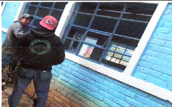
Sustitución de ventanas de madera por ventana marco de metal con Tee de 3/4 legítimo
