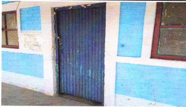
Sustitución de puertas de madera por puertas de metal con Lámina 364 chapa Yale.
