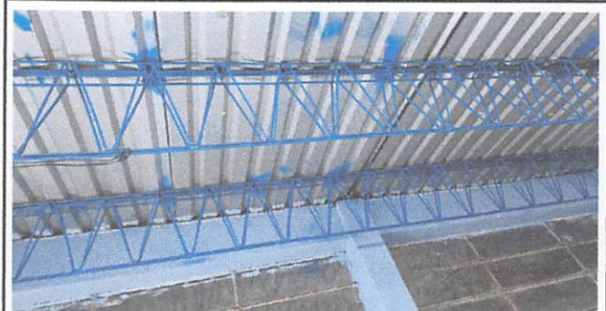
Foto 4: Acabado final de pintura en vigas del techo de dos aulas equivalente a 63 m² módulo 1.
