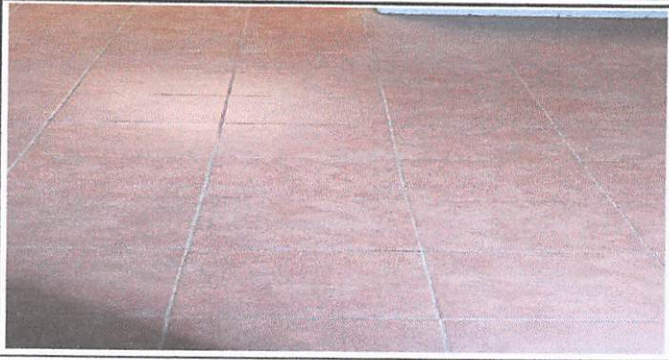
Foto 1: Acabado final de 48m² de piso cerámico en dirección y cocina módulo 1.
