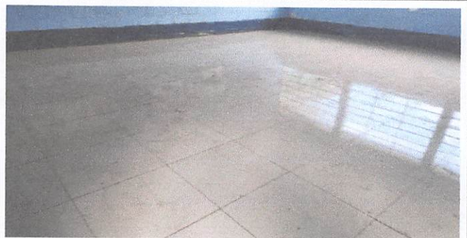
Foto 3: Terminada de 127 m² de piso cerámico en las dos aulas módulo 1.
