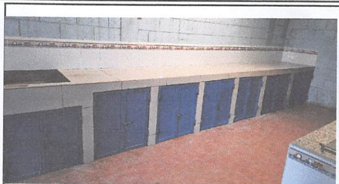
Foto 2: Acabado final de 15m² de azulejo en mesa de trabajo en cocina módulo 1.
