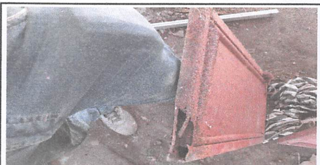
Foto 6: Mantenimiento correctivo de 9 puertas para gabinetes en mesa de trabajo incluye lijado y pintado en cocina módulo 1.
