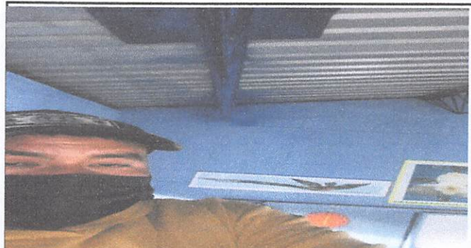
Foto 4: Suministro de pintura Sherwin Williams Azul Dryve en vigas metálicas del techo de dos aulas equivalente a 63 m² módulo 1.
