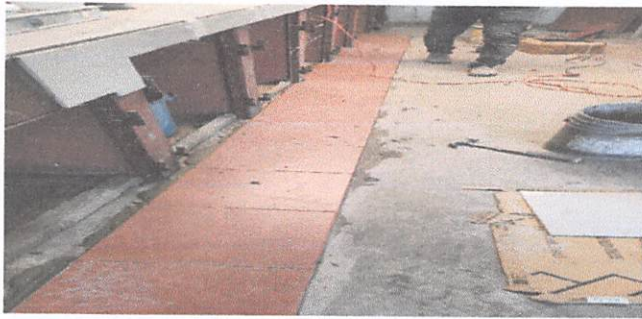
Foto 1: Sustrucción de piso de cemento por 48 m² de piso cerámico en Dirección y cocina módulo 1,
