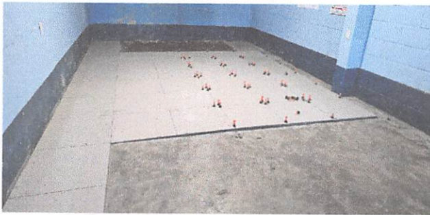
Foto 3: Sustrucción de piso de cemento por 127 m² piso de cerámico en aulas de ingreso principal de módulo 1.
