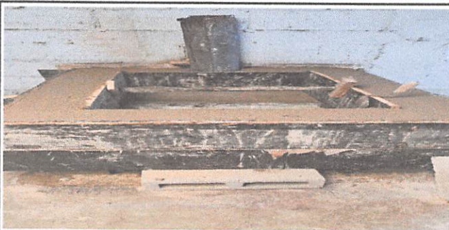
Foto 5: Sustrucción de 2 estufas existentes por estufas más azulejo y chemeña de concreto en cocina módulo 1.
