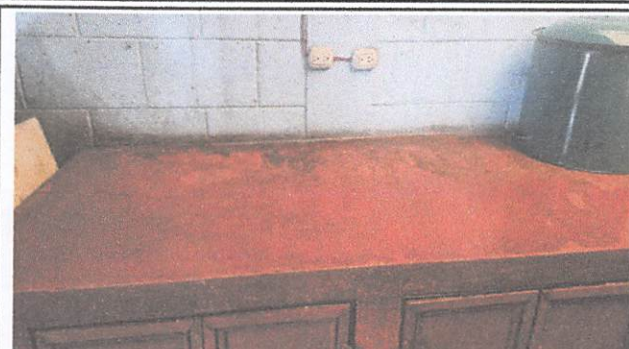
Sustitución de acabado alizado de cemento por 15m 2 de azulejo en mesa de trabajo en cocina módulo 1.
