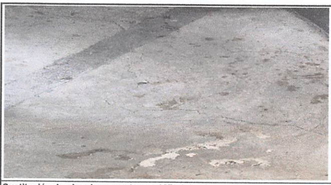
Sustitución de piso de cemento por 127m 2 de piso cerámico en aulas de ingreso principal módulo 1.
