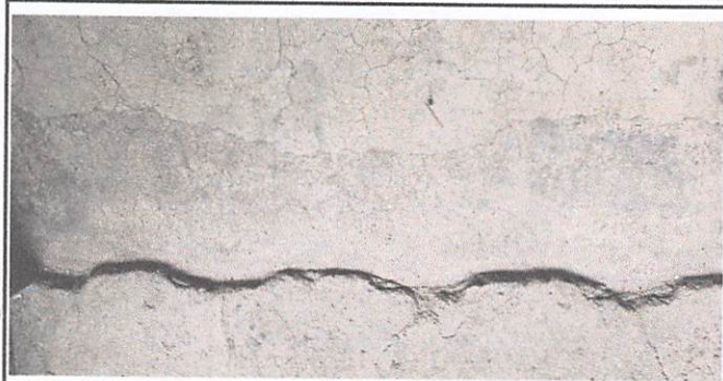
Sustitución de piso de cemento por 48m 2 de cerámico en dirección y cocina módulo 1.
