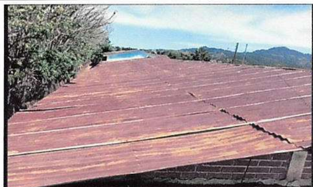
Sustitución de lámina, por lamina troquelada Calibre 26 en modulo 1
