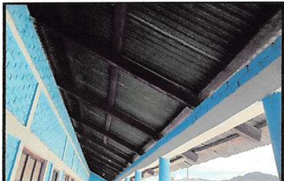
sustitución de estructura de soporte de madera por metal en módulo 1,
