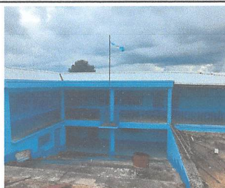
Foto 10: Mantenimiento de barandas 2do. Nivel con pintura de aceite fas dray secado rápido Sherwin Williams incluye limpieza y lijado, color azul modulo 1. (24 m2)
