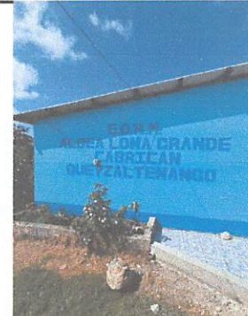
Foto 12: Sustitución de letrero oficial de la escuela( incluye elaboración de marcos de letras, rotulación y aplicación de pintura en letras) . (41 unidades)
