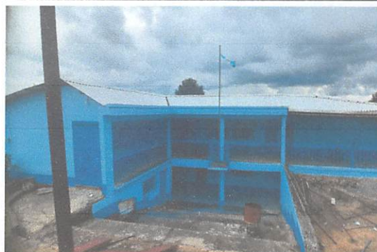
Foto 4: Mantenimiento y aplicación de pintura Sherwin Williams color celeste para muros exteriores aulas 1ro. Y 2do. Nivel fachada frontal. Módulo 1. (250 m2)
