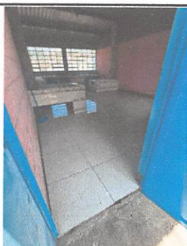
Foto 5: Sustitución de piso de concreto por piso porcelanato 60x60 cms. para cocina módulo 1. ( 26 m2)
