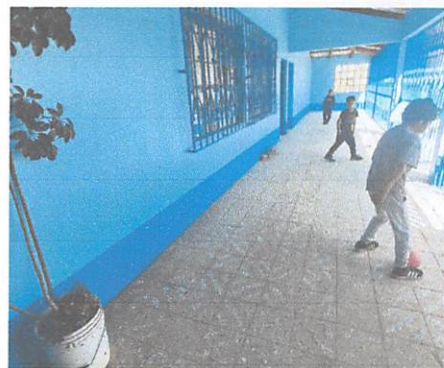
Foto 2: Mantenimiento y aplicación de pintura de aceite corona color azul para sáculo en interior de salón + muros exteriores de aulas módulo 1. (38 m2)
