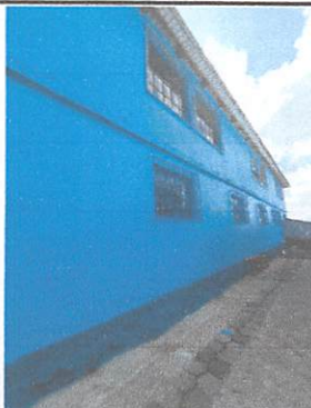
Foto 3: Mantenimiento y aplicación de pintura de aceite corona color celeste para muros exteriores de aulas 1er. Y 2do. Nivel módulo 1. (117 m2)
