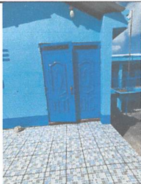
Foto 13: Sustitución de piso de concreto por piso antideslizante ingreso a escuela 2do. nivel módulo 1. (5 m2)
