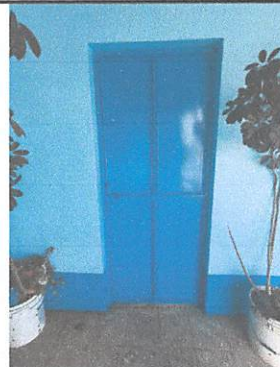
Foto 8: Mantenimiento en puertas de metal con pintura de Aceite Fas Dray Sherwin Williams Secado Rápido color azul módulo 1 (incluye limpieza y lijado). (9 unidades)
