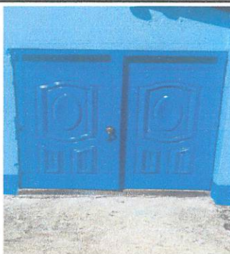
Foto 11: Sustitución portón de ingreso de metal por portón de metal. Módulo 1. (1 unidad)
