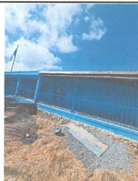
Foto 6: Instalación de baranda de metal segundo nivel altura 1.10 Mts. con tubo cuadrado de 1" módulo 1. ( 29 m2)
