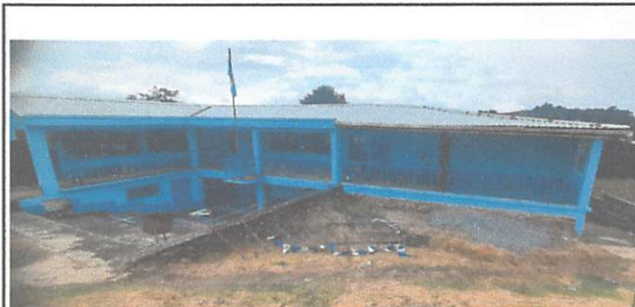
Foto 6: Instalación de baranda de metal segundo nivel altura 1.10 Mts. con tubo cuadrado de 1" módulo 1. ( 29 m2)
