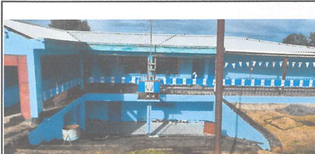
Foto 4: Mantenimiento y aplicación de pintura Sherwin Williams color celeste para muros exteriores aulas 1ro. Y 2do. Nivel fachada frontal. Módulo 1. (250 m2)
