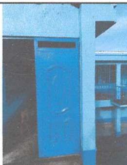
Foto 11: Sustitución portón de ingreso de metal por portón de metal. Módulo 1. (1 unidad)
