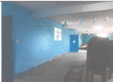
Foto 1: Mantenimiento y aplicación de pintura corona clásica latex a base de agua color celeste en muros interiores de salón módulo 1. (138 m2)
