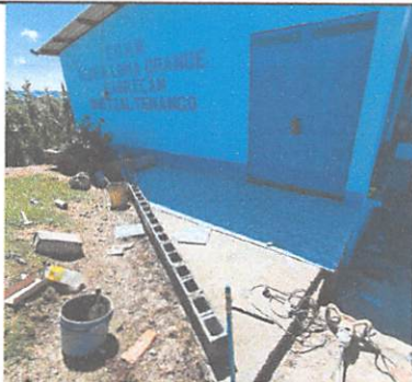
Foto 13: Sustitución de piso de concreto por piso antideslizante ingreso a escuela 2do. nivel módulo 1. (5 m2)
