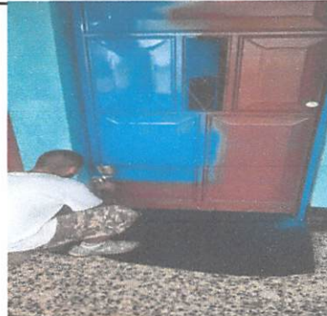
Foto 8: Mantenimiento en puertas de metal con pintura de Aceite Fas Dray Sherwin Williams Secado Rápido color azul módulo 1 (incluye limpieza y lijado). (9 unidades)
