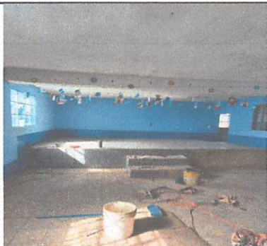
Foto 7: Mantenimiento Correctivo de escenario en Salón, con azulejo módulo 1. (5 m2)
