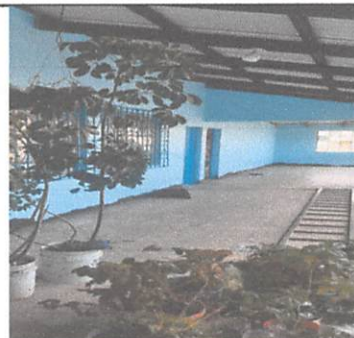
Foto 2: Mantenimiento y aplicación de pintura de aceite corona color azul para socalo en interior de salón + muros exteriores de aulas módulo 1. (38 m2)
