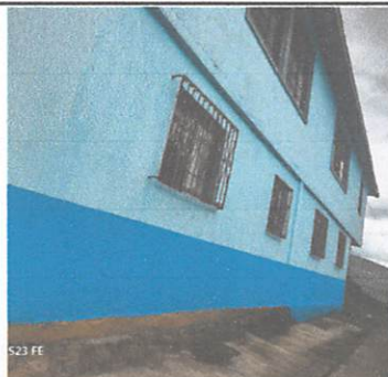
Foto 3: Mantenimiento y aplicación de pintura de aceite corona color celeste para muros exteriores de aulas 1er. Y 2do. Nivel módulo 1. (117 m2)
