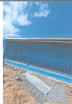
Foto 10: Mantenimiento de barandas 2do. Nivel con pintura de aceite fas dray secado rápido Sherwin Williams incluye limpieza y lijado, color azul modulo 1. (24 m2)
