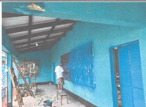
Foto 9: Mantenimiento de balcones en aulas 1ro. Y 2do. Nivel módulo 1, con pintura de aceite Sherwin William fas dray secado rápido incluye limpieza y lijado, color azul. (28 m2)
