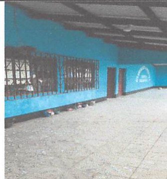
Mantenimiento y aplicación de pintura de aceite corona color azul para sáculo en interior de salón + muros exteriores de aulas módulo 1. (38 m2)
