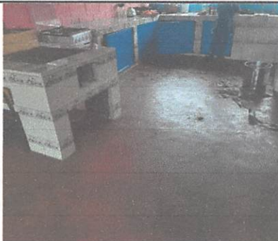
Sustitución de piso de concreto por piso porcelanato 60x60 cms. para cocina módulo 1. (26 m2)
