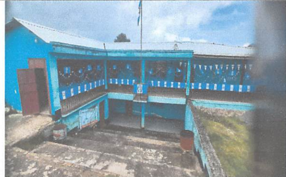
Mantenimiento y aplicación de pintura Sherwin Williams color celeste para muros exteriores aulas 1ro. Y 2do. Nivel fachada frontal. Módulo 1. (250 m2)
