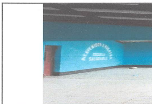
Sustitución de letrero oficial de la escuela( incluye elaboración de marcos de letras, rotulación y aplicación de pintura en letras) (41 unidad)
