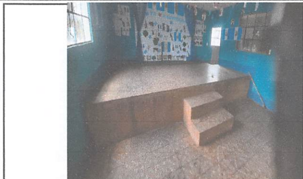
Mantenimiento Correctivo de escenario en Salón, con azulejo módulo 1. (5 m2)
