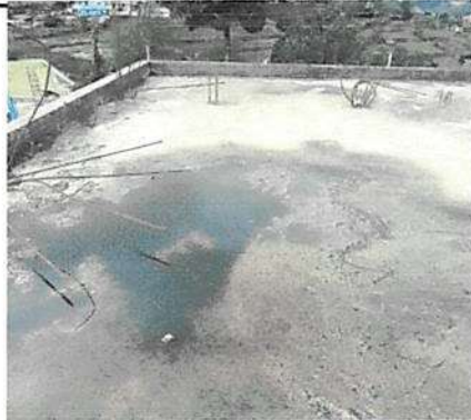
Impermeabilización de losa con bloqueador ACUALOK 10 años en modulo 3.
