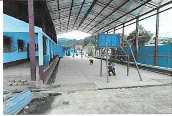
Suministro y aplicación de pintura para muro exterior Zócalo, latex azul pantone 293 marca Goltex.
