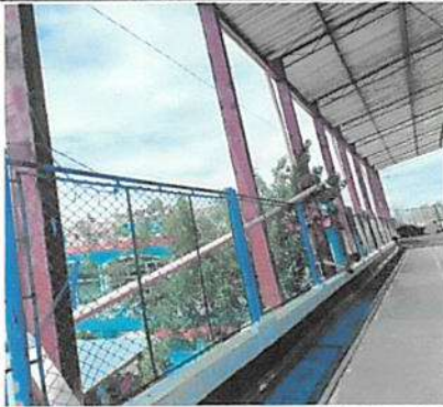
Sustitución de bajada de agua pluvial por tubo PVC de 4 pulgadas en techo de cancha deportiva.
