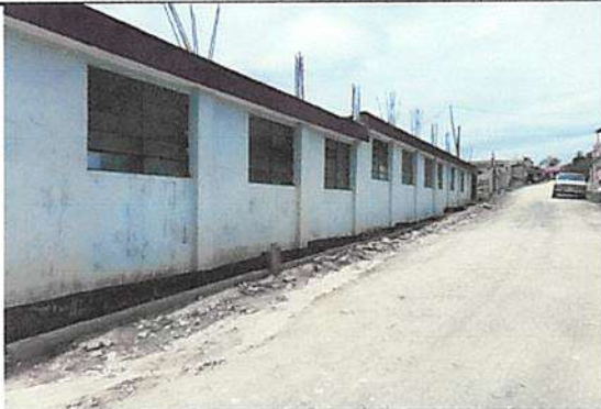
Suministro y aplicación de pintura exterior ,latex celeste pantone 293 marca Goltex en modulo 1,2 , 3 baños y cocina.
