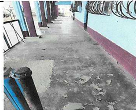
Reparación Preventiva de planchas de concreto en pasillos de módulo 1.
