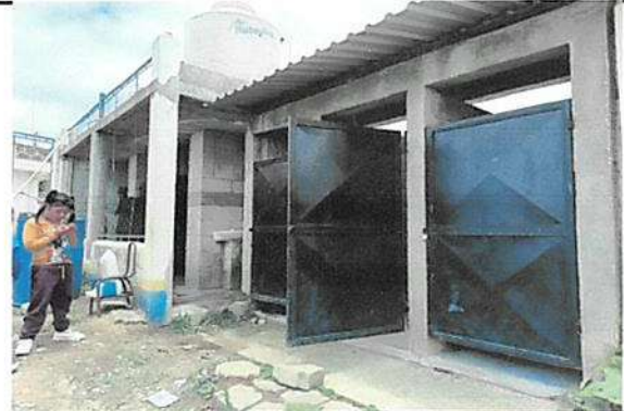
Sustitución de depósito de agua 2500 litros, marca rótoplas.
