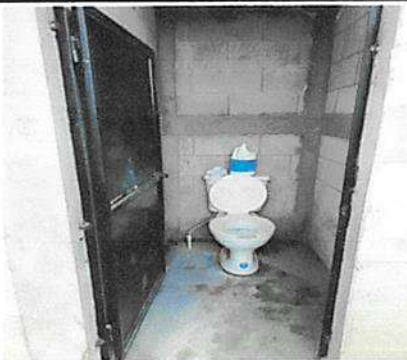
Sustitución de inodoro elongado, marca American estándar.
