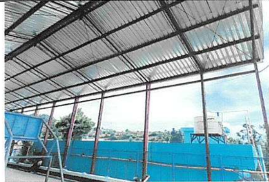
Sustitución de canal de metal del techo de cancha deportiva.
