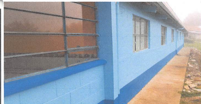
suministro de pintura exterior latex celeste pantone 293 (sherwin Williams) para muros módulo 1 = 210 mts
