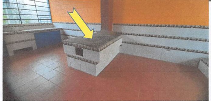
Reparacion de estufa existente con azulejo y sustitucion de plancha de metal mas chimenea de concreto en cocina módulo 1 = 1 unidad
