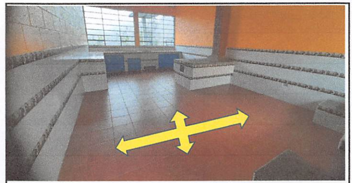
Sustitucion de piso alisado de cemento por piso cerámico en cocina modulo 1 = 32 mts
