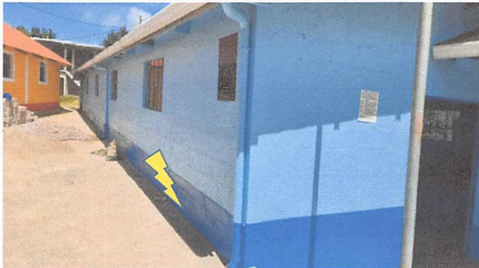
Suministro y aplicación de pintura exterior latex celeste pantone 293 (sherwin Williams) para Zócalo módulo 1 = 61 mts
