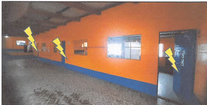
Mantenimiento correctivo puertas de aulas y cocina (incluye lijado y pintura final) módulo 1 = 4 unidades
