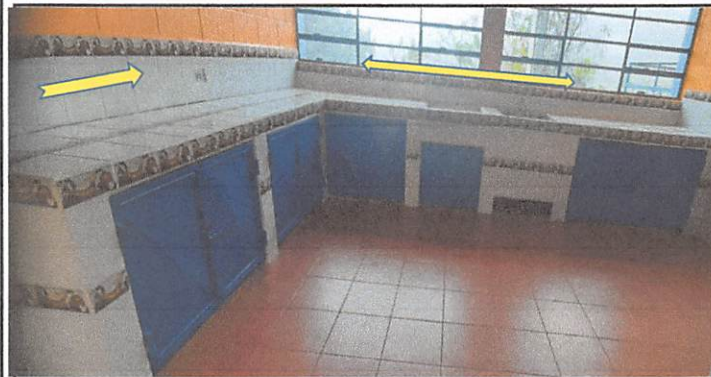
Sustitucion alisado de cemento por azulejo en mesa de trabajo en cocina modulo 1 = 28 mts
