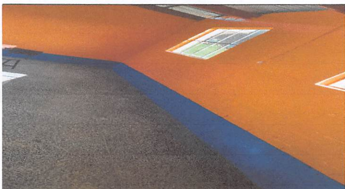
Suministro y aplicación de pintura latex Sherwin Williams) para aulas y cocina interior modulo 1 = 320 mts
