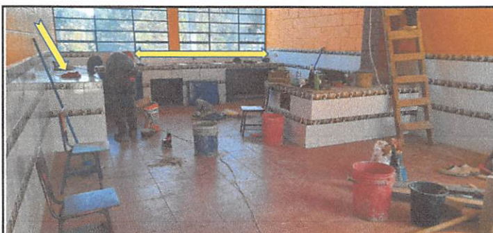
sustitucion alisado de cemento por azulejo en mesa de trabajo en cocina modulo 1= 28 mts
