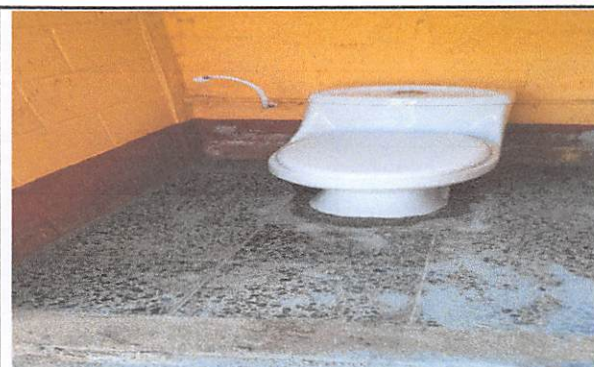
Sustitucion de inodoros elongados en baños de niñas y niños moduulo 1 = 3 unidades
