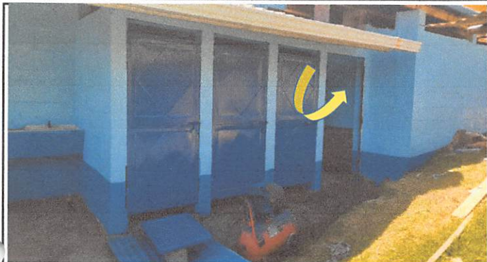
Sustitucion de puerta de madera por puerta de metal en área de baño módulo 1= 1 unidad
