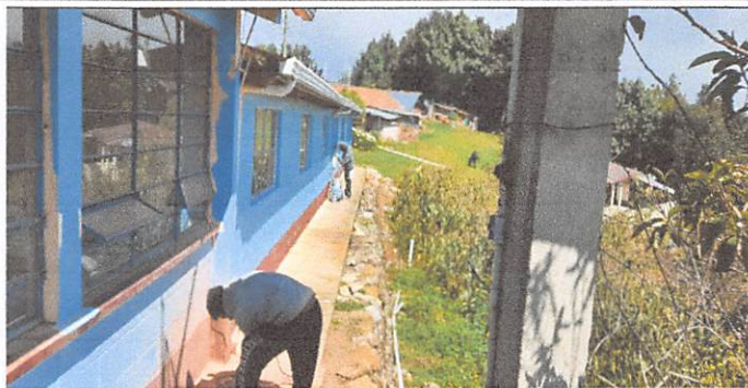
Suministro y aplicación de pintura exterior latex celeste pantone 293 (sherwin Wiliams) para Zócalo módulo 1 = 61 mts
