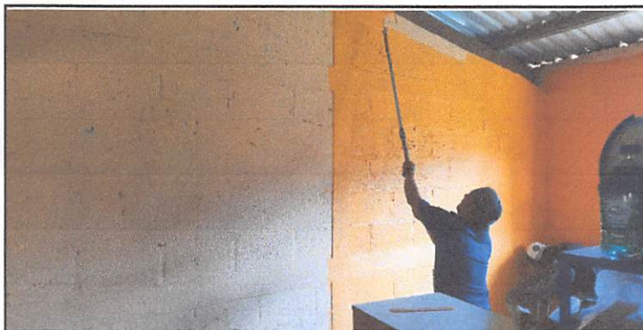
Suministro y aplicación de pintura latex Sherwin Wiliams) para aulas y cocina interior modulo 1 = 320 mts
