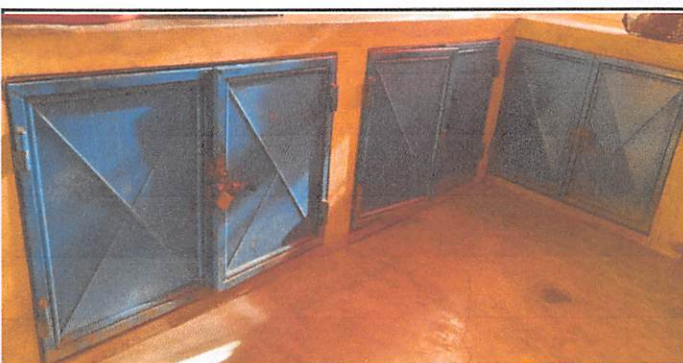
Mantenimiento correctivo de puertas de gabinetes (incluye lijado y pintura final modulo 1= 5 unidades
