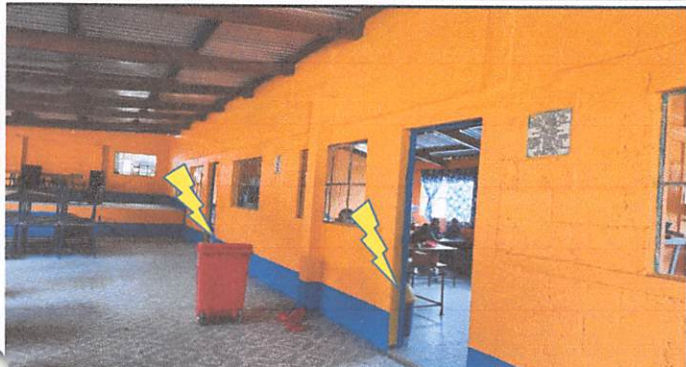
Mantenimiento correctivo puertas de aulas y cocina (incluye lijado y pintura final) módulo 1= 4 unidades
