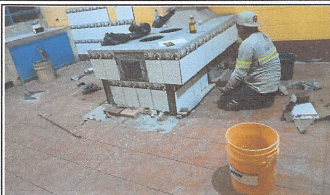
Reparacion de estufa existente con azulejo y sustitucion de plancha de metal mas chimenea de concreto en cocina módulo 1= 1 unidad
