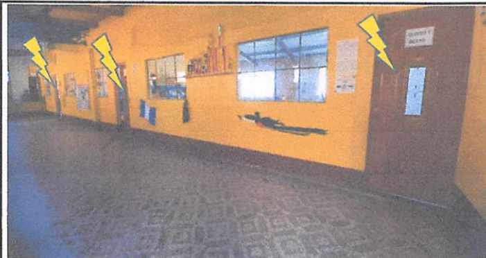
Mantenimiento correctivo puertas de aulas y cocina (incluye lijado y pintura final) módulo 1
