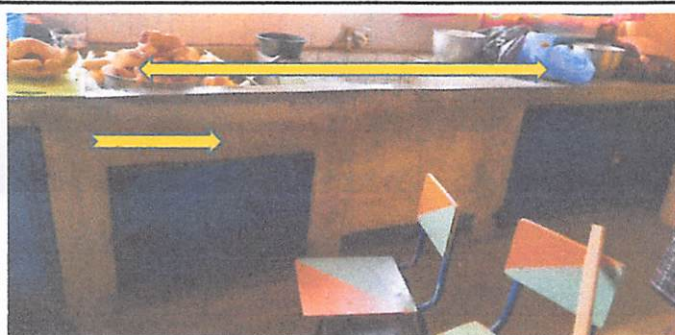
Sustitución alisado de cemento por azulejo en mesa de trabajo en cocina modulo 1
