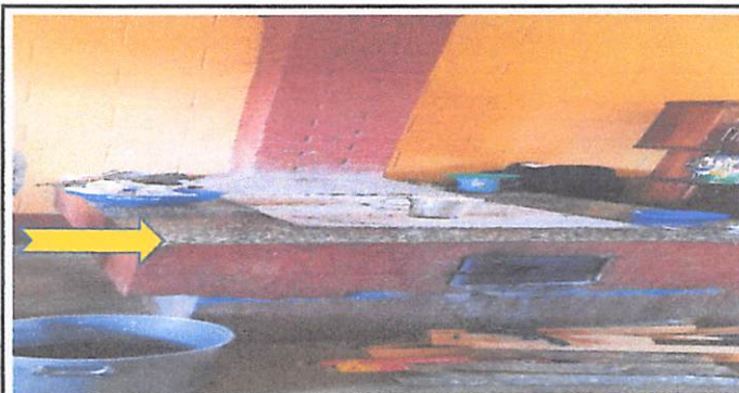
Reparacion de estufa existente con azulejo y sustitucion de plancha de metal mas chimenea de concreto en cocina módulo 1
