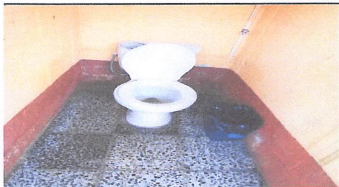
Sustitucion de inodoros elongados en baños de niñas y niños modulo 1
