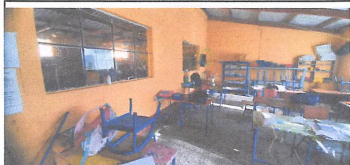
Suministro y aplicación de pintura latex Sherwin Wiliams) para aulas y cocina interior modulo 1
