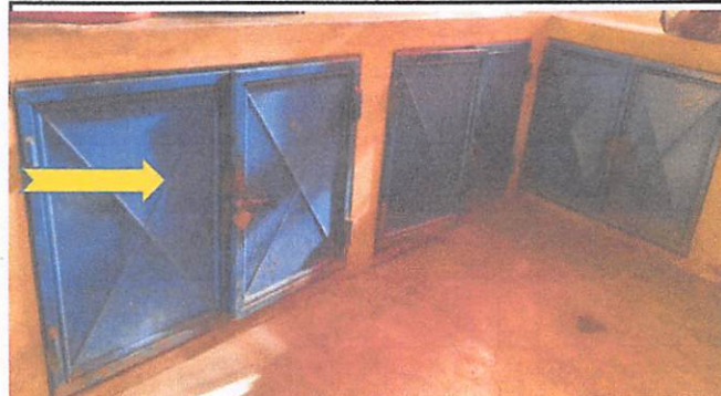
Mantenimiento correctivo de puertas de gabinetes (incluye lijado y pintura final modulo 1
