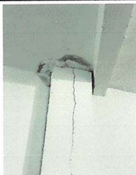
Sustitución dos estufas con chimenea de concreto en cocina módulo 1, incluye demolición en estufas y chimeneas existentes
