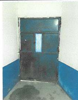
Sustitución de puertas metalicas para cocina módulo 1
