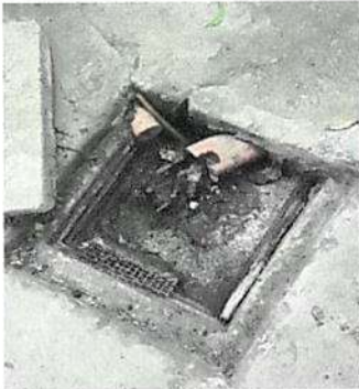
Sustitución de caja registro para drenaje de pila en cocina módulo 1
