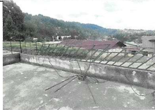
Sustitución de baranda de metal en terraza aula módulo 1
