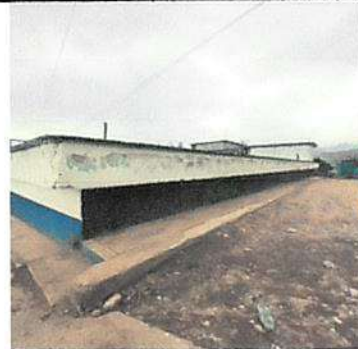
Suministro y aplicación pintura Exterior latex azul pantone 293 para zocalos aula y cocina módulo 1
