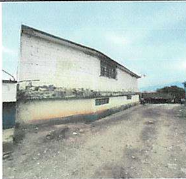
Suministro y aplicación pintura Exterior latex celeste pantone 293 para muros aula y cocina módulo 1
