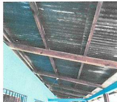
Sustitución de estructura de soporte por metal
