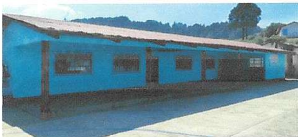
Sustitución de lámina por lámina troquelada calibre 26
