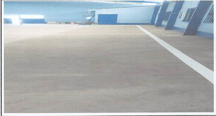
Foto 2: Mantenimiento correctivo de piso de cemento decorado por torta de concreto con cemento progreso 4,000, arena y piedrin en cancha de escuela. 180 m2
