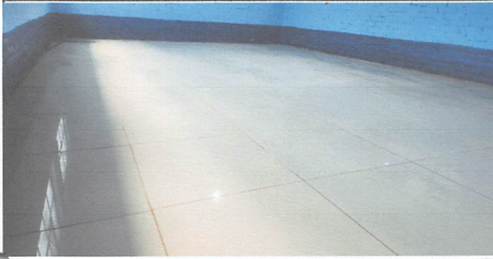
Foto 1: Sustitucion piso de cemento decorado por piso ceramico de 60x60 cm pegado con psp maípe en aulas modulo 1. 222 m2
