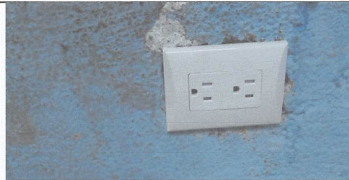
Foto 3: Sustitución de tres tomacorrientes en aulas de modulo 1. 6 unidades
