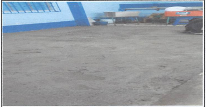
Foto 2: Mantenimiento correctivo de piso de cemento decorado por torta de concreto con cemento progreso 4,000, arena y piedrin en cancha de escuela. 180 m2
