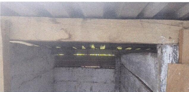
Sustitucion de Estructura portante de madera a Estructura de metal, en baños del modulo 2
