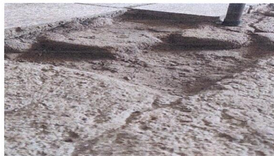
Nivelacion de piso, con torta de concreto en cocina en modulo 1
