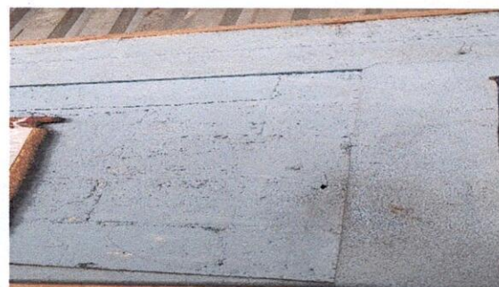
Suministro y aplicación Pintura interior látex, en cocina, en modulo 1
