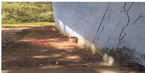
Sustitucion de drenaje para pila, Sustitución de tubería PVC linea principal aguas pluviales 4" con recubrimiento de concreto, en modulo 1
