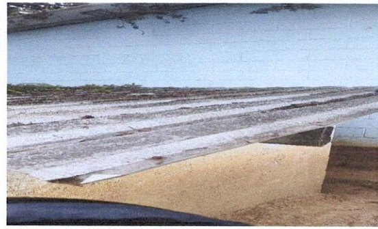
Sustitucion de Lamina por Lamina troquelada Calibre 26, en baños del modulo 2
