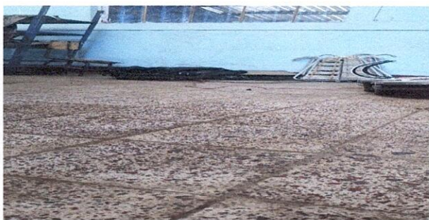
Instacion de piso ceramico, en cocina, en modulo 1
