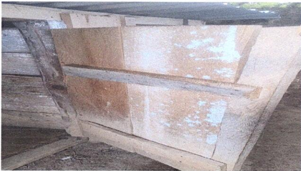
Sustitucion puerta de madera a puerta de metal en baños del modulo 2
