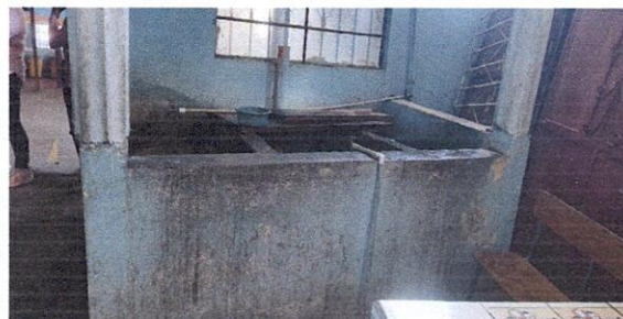
Sustitucion de pila de dos lavaderos, en cocina, en modulo 1
