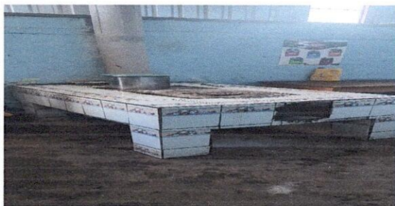
Sustitucion de 2 planchas en cocina, azulejadas con chimeneas de tubo de concreto en modulo 1
