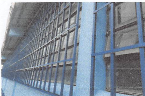
Foto 5: Mantenimiento preventiva con Suministro y aplicación de pintura anticorrosiva en balcones de aulas. 18 m2.
