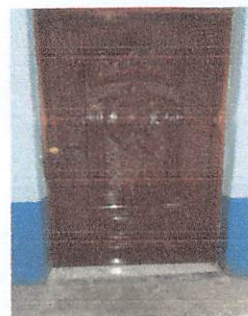
Foto 4: Sustitución de estructura metálica de puerta en dirección. 1 unidad
