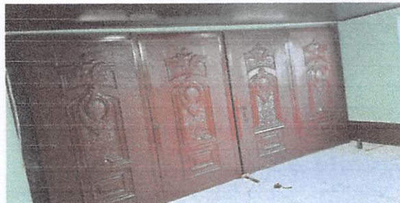
sustitución de entrepaño de madera por entrepaño de metal 4.70 x 2.20 m2 en dirección 1 unidad
