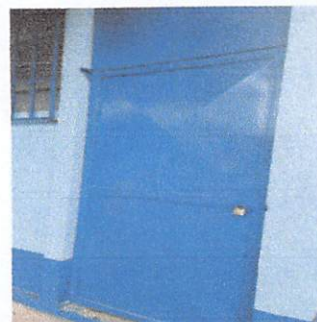
Foto 6: Mantenimiento de estructura metálica de puerta incluye (reparación, lijado y aplicación de pintura) en aulas. 8 unidades
