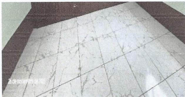
Foto 3: Sustitución de piso de concreto por piso porcelanato en dirección.20 m2.
