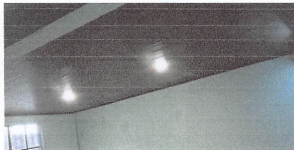
Foto1: Mantenimiento preventivo e instalación de cielo falso de PVC en dirección 20 m2.
