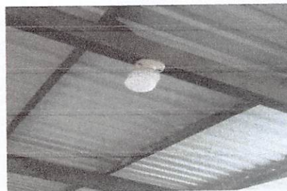
Foto 8: Sustitución de bombillos led 25 w por bombillos led 100w en aulas. 8 unidades
