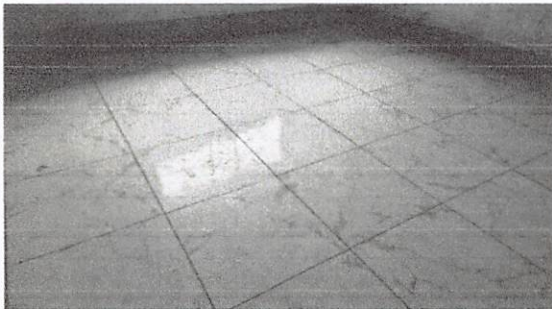
Foto 3: Sustitución de piso de concreto por piso porcelanato en dirección. 20 m2.
