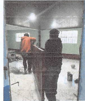
Foto 2: Sustitución de entrepaño de madera por entrepaño de metal 4.70 x 2.20 m2 en dirección. 1 unidad
