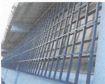
Foto 5: Mantenimiento preventivo con Suministro y aplicación de pintura anticorrosiva en balcones de aulas. 18 m2.
