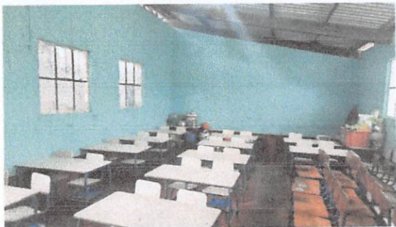
Foto 7: Mantenimiento preventivo de muros con Suministro y aplicación de pintura látex Sherwin Williams en interior y exterior de aulas. 711 m2.
