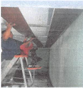
Foto1: Mantenimiento preventivo e instalación de cielo falso de PVC en dirección 20 m2.
