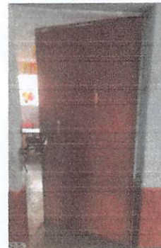
Foto 4: Sustitución de estructura metálica de puerta en dirección. 1 unidad
