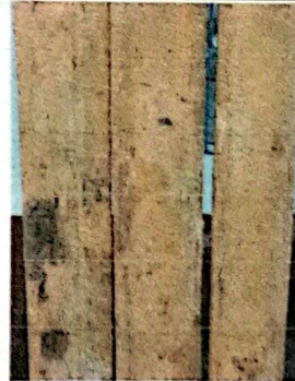
Sustitución de entrepaño de madera por entrepaño de metal de 4.70 x 2.20 m2 en direccion.
