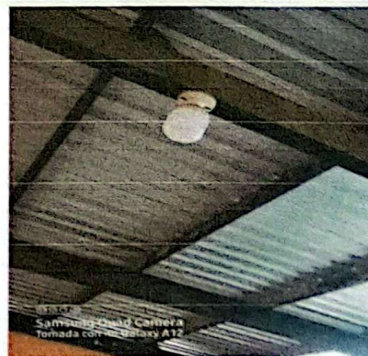
Sustitución de bombillos led 25 w por bombillos led 100w en aulas.
