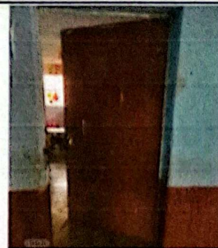
Sustitución de estructura metalica de puerta de dirección
