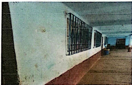
Mantenimiento preventivo de muros con Suministro y aplicación de pintura látex Sherwin Williams en interior y exterior de aulas
