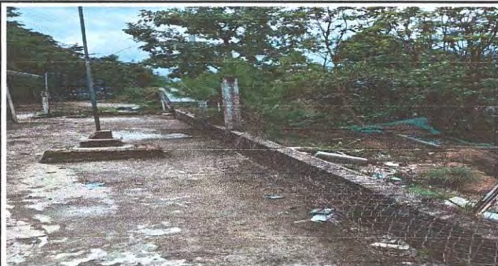
Mantenimiento correctivo de muro con sustitucion de cerco perimetral metalico con malla calibre 14
