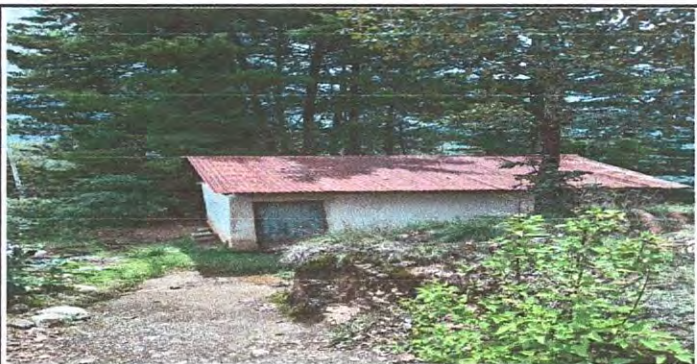
suministro e instalacion lamina troquelada calibre 26 cocina
