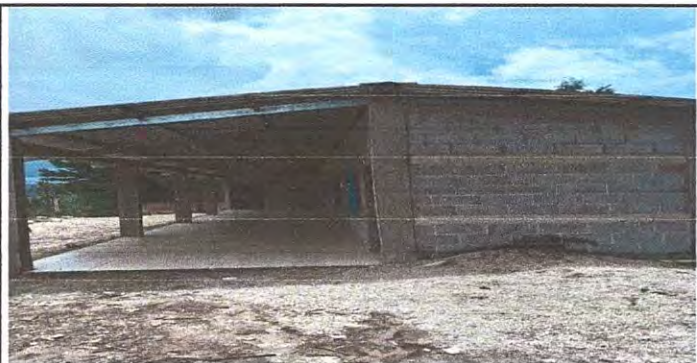
Suministro y aplicación pintura interior
