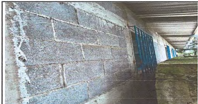
suministro y aplicación pintura exterior
