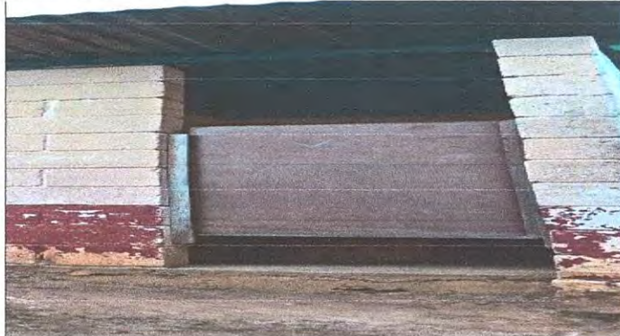
Sustitucion de puertas de metal en servicios sanitarios
