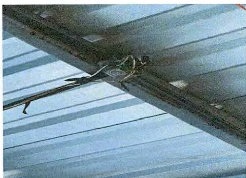
Mantenimiento correctivo de sistema electrico con Suministro e instalación de tubo de vinil 3/4 en direccion, aulas y cocina de modulo 1.
