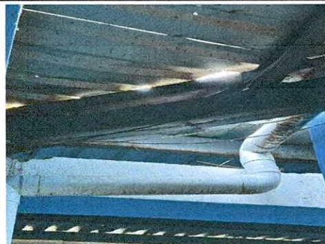
Mantenimiento correctivo de sistema electrico con Suministro e instalación de tubo vinil en en direccion, aulas y cocina de modulo 1.
