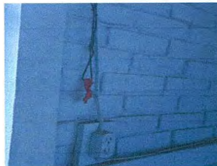
Mantenimiento correctivo de sistema electrico con Montaje de tomacorrientes marca B-Ticino de ampalmado y encintado en direccion, aulas y cocina de modulo 1.
