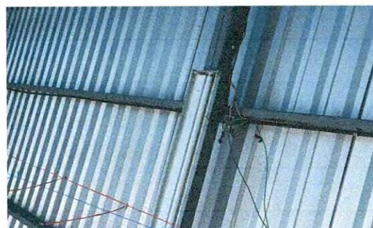
Mantenimiento correctivo de sistema electrico con Suministro e instalación colocación de vueltas y conectores en direccion, aulas y cocina de modulo 1.
