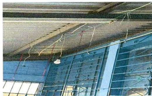
Mantenimiento correctivo de sistema electrico con Recableado Cable No. 10 CONDUMEX en direccion, aulas y cocina de modulo 1.
