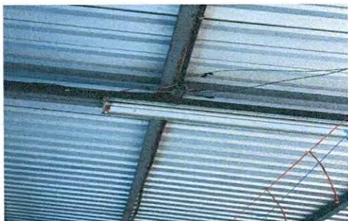
Mantenimiento correctivo de sistema electrico con Colocación de abrazaderas 3/4 marca Handle en direccion, aulas y cocina de modulo 1.
