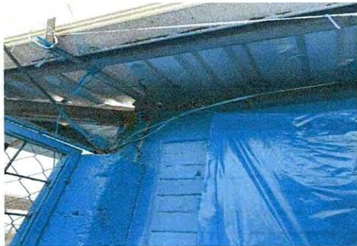
Mantenimiento correctivo de sistema electrico con Recableado Cable No. 12 CONDUMEX en direccion, aulas y cocina de modulo 1.
