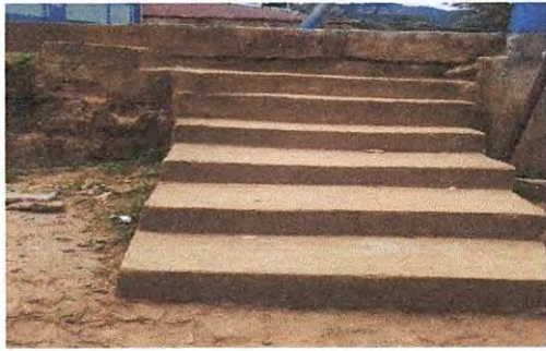
Sustitución de gradas de concreto por gradas de concreto armado módulo 2.
