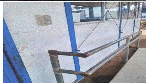
Mantenimiento de Pintura en aulas muros de lámina exterior Sherwin Williams Fast Dryve celeste secado rapido Pantone 293.
