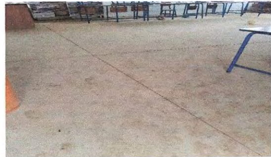
Sustitución Planchas Piso de cemento por piso vinil en aulas módulo 2.
