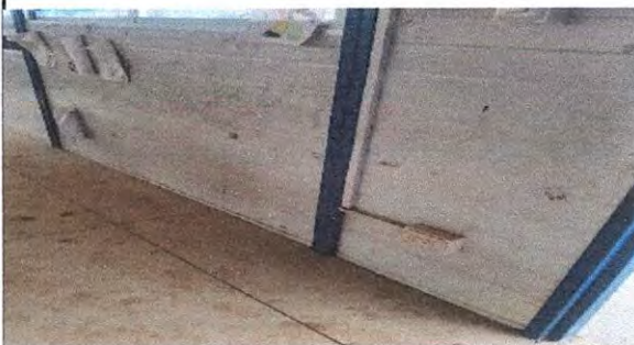
Mantenimiento de Pintura en aulas muros de lámina interiores Sherwin Williams Fast Dryve celeste secado rapido Pantone 293.
