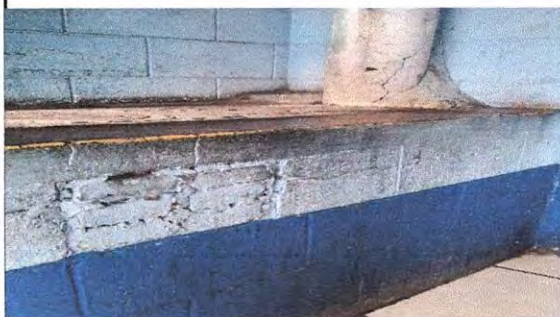
Reparación de estufa existente con azulejo más chimenea de concreto módulo 1.
