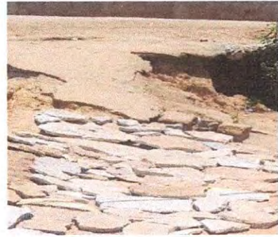
Mantenimiento correctivo de planchas de concreto en entrada de módulo 1.
