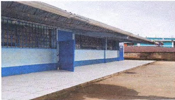
Sustitución Canal PVC por canal PVC aulas módulo 1.
