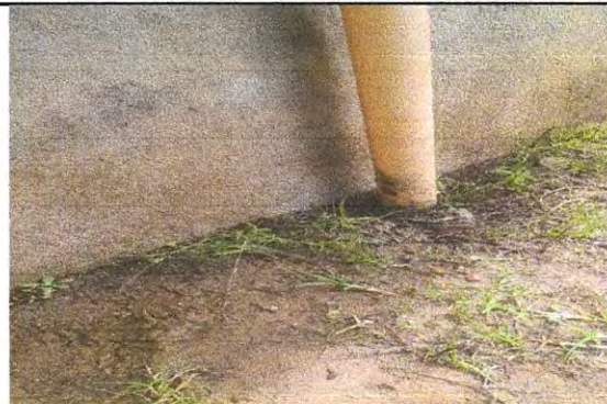
Sustitución de tubo de drenaje de 3" y línea de agua potable cocina
