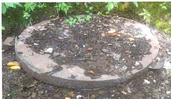
Sustitución de brocal de pozo de agua en patio
