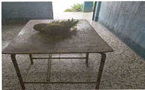
Mantenimiento de mesa de trabajo por mesón de concreto con azulejo de 4.70 m por 1 m de ancho, gabinetes y puertas en PVC. De 85 cm. Por 4.30 m. de largo
