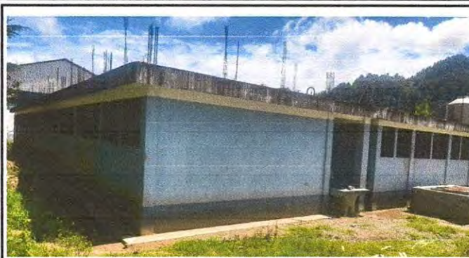
Mantenimiento de muro con aplicación de pintura exterior marca Sherwin William en aulas de modulo 1
