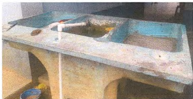
Sustitución de pila de concreto por lavatrastos de concreto reforzado con azulejo
