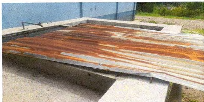
Sustitución de tapadera de pila en metal en patio
