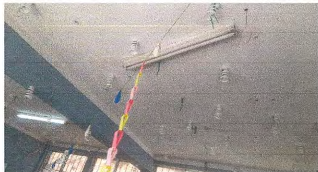
Reparación e instalación de lamparas en aulas de 10 whatss modulo 1
