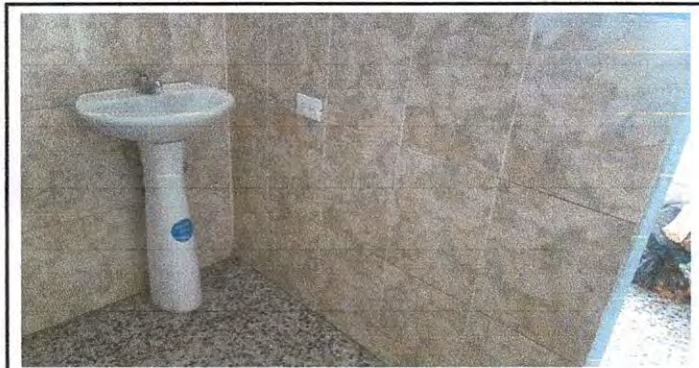
Sustitución de mingitorio en baños reforzado con azulejo
