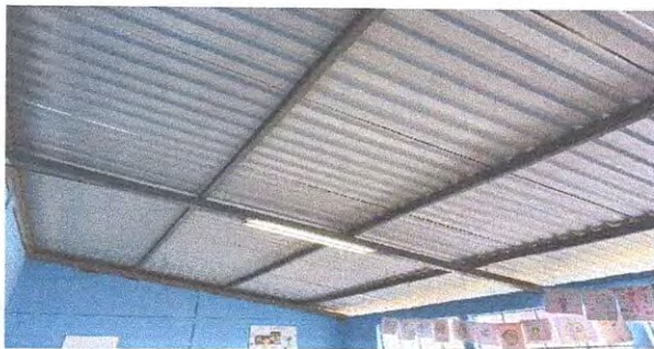
Mantenimiento correctivo de techo y muros con sellado de aberturas con lanchas de vinil en aulas de modulo 1. ,
