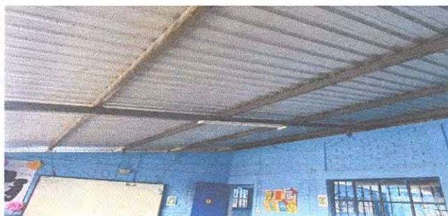
Mantenimiento preventivo de techo con suministro e instalacion de cielo falso de PVC reticulado en aulas de modulo 1
