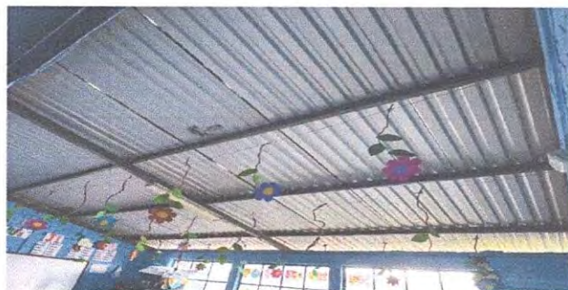
Mantenimiento preventivo de techo con suministro e instalacion de cielo falso de PVC reticulado en aulas de modulo 1
