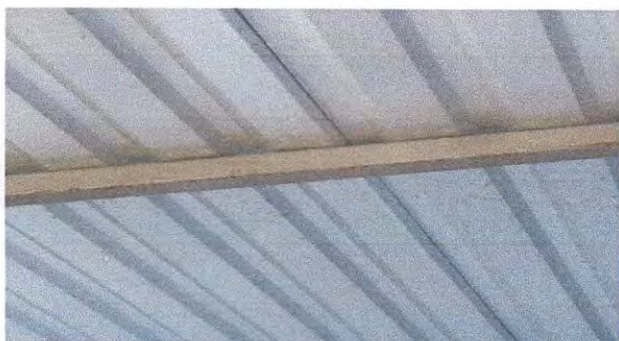
Mantenimiento preventivo de techo con suministro e instalacion de cielo falso de PVC reticulado en aulas de modulo 1
