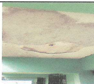
Repello en losa interior en aula módulo 1
