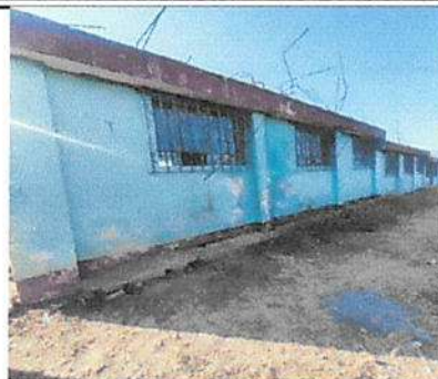
Suministro de aplicación pintura exterior latex azul phantom 293 para zocalo módulo 1
