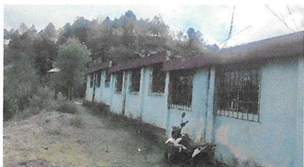
Suministro y aplicación pintura exterior latex celeste phantom 293 para muros de aulas de módulo 1, cocina y baños
