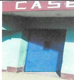
Mantenimiento de puertas de metal módulo 1(incluye lijado y pintado)
