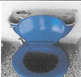
Sustitución de inodoro elongados en baños módulo 1
