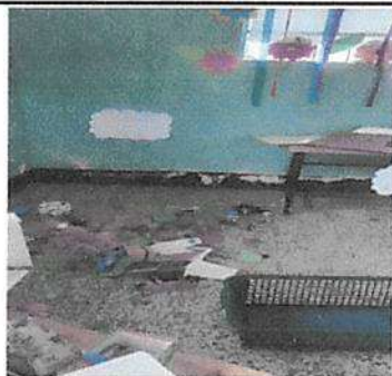
Suministro de aplicación pintura interior latex lavable(limpieza, resane y aplicación) en aulas módulo 1, cocina y baños
