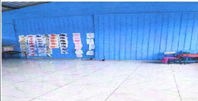
Sustitución de entrepaño de madera por entrepaño metálico de de 4.90 x 2.86 con lámina 1-16 tubo de 3x1 chapa 18 con marco de 1 pulgada original módulo 1
