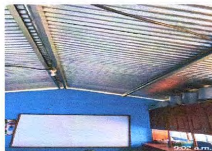
Sellado de abertura entre muro y techo
