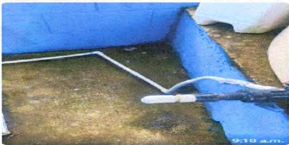
Sustitución de línea de agua potable de rotoplas.
