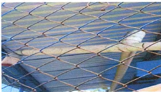
Suministro y aplicación de pintura anticorrosiva Sherwin Williams en
