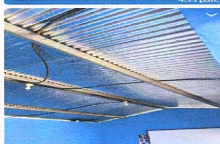
Mantenimiento preventivo e intalación de cielo falso de pvc en cocina
