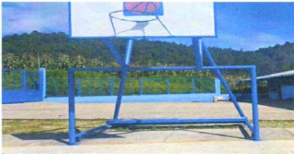
Sustitución de rodos de canastas
