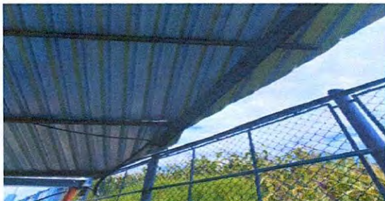
Sustitución de lámina de 22 pies troquelada calibre 27
