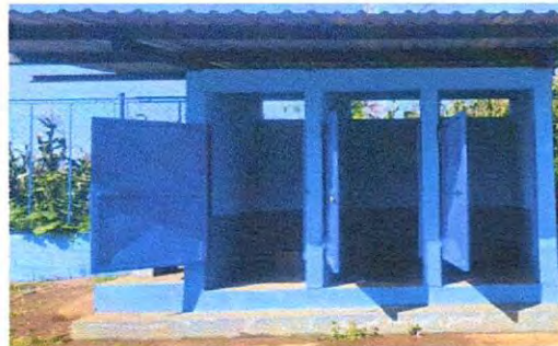
Sustitución de base y piso de baños sanitarios
