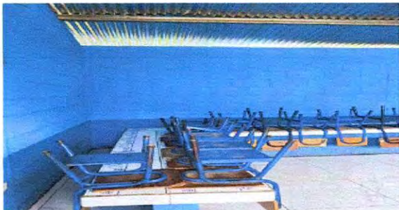
Suministro y aplicación de pintura latex Sherwin Williams en cocina interior.
