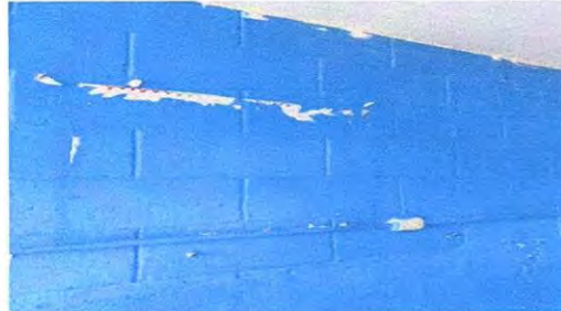
Suministro y aplicación de pintura latex Sherwin Williams en interior de aulas módulo 1
