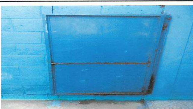
Foto 4: Reparación de 3 puertas de baño , lijado y pintado
