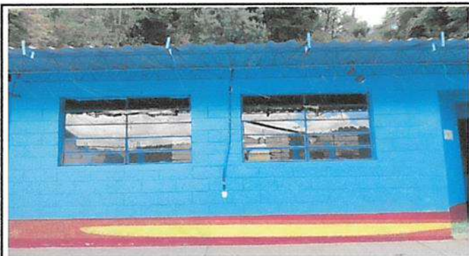
Foto 3: colocación de balcones de tubos de 3 cuartos con pintura en modulo 1 y 2
