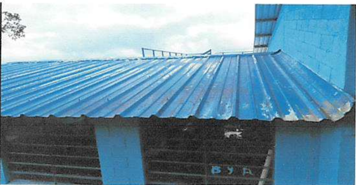
Mantenimienrto de pintura en techo
