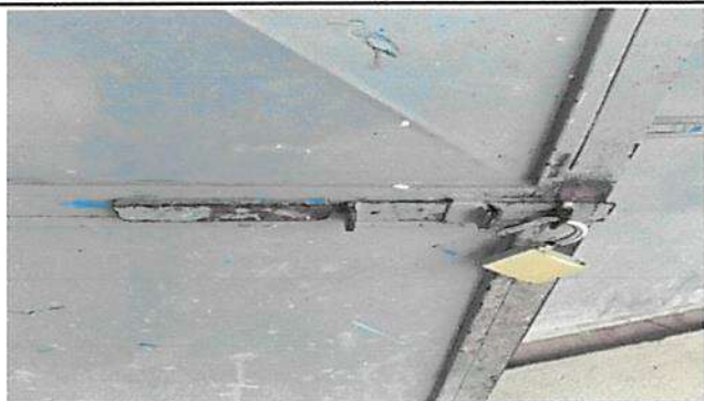
Sustitucion de poasadores por chapa 5 modulos
