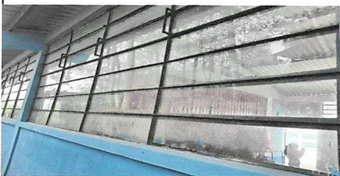
Mantenimiento y sustitucion de barandas e instalación de balcones modulo 2 y 3
