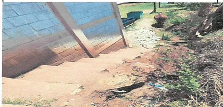
Sustitución empedrado por adoquin modulo 7
