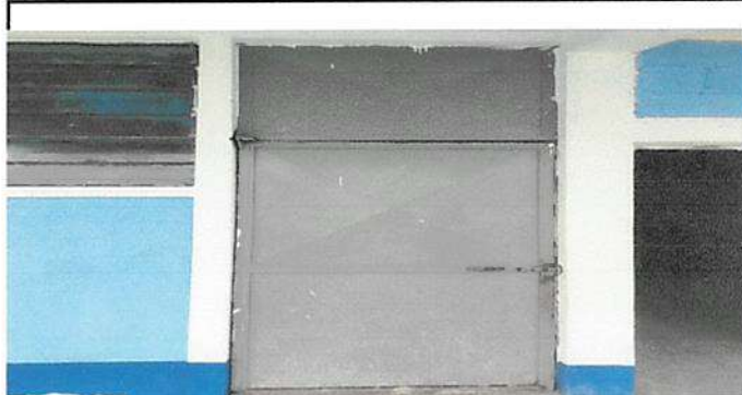
Reparación de 3 puertas en marco modulo 2,3 y 4
