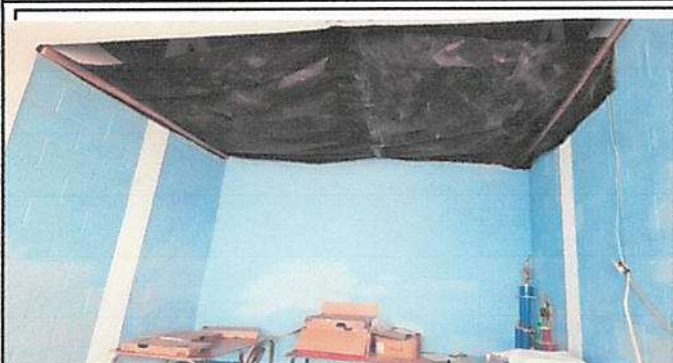
Cielo Falso Modulo 1
