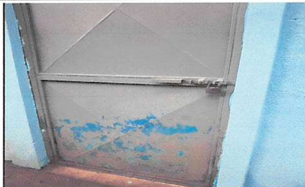
Sustitucion mantenimiento de puertas en pintura 6 modulos
