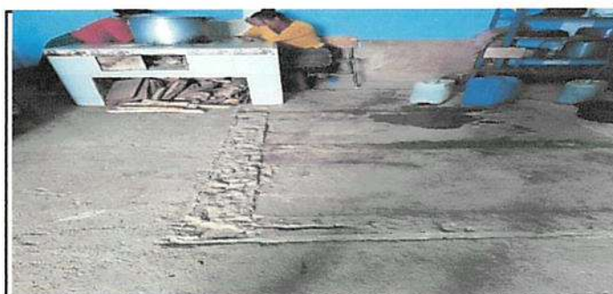
Sustitución piso rustico por granito modulo 4 cocina
