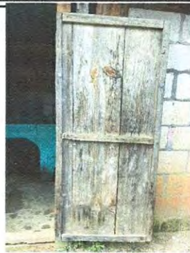
Sustitución de puertas de madera por puertas de metal en área de lavamanos módulo 2.
