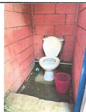
Sustitución de Inodoros elongados en baños de niños y niñas módulo 2.
