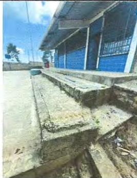
Reparación Gradas en Cancha módulo 1.
