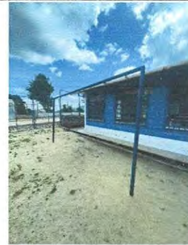
Sustitución Porterías en cancha módulo 1 y 2.
