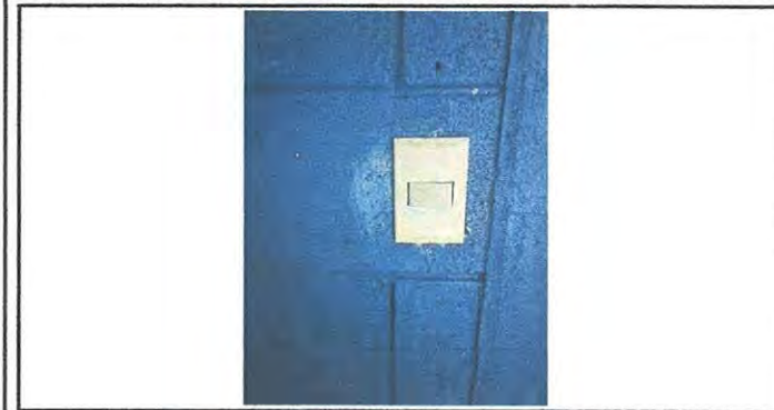
Sustitución Interruptor por Tomacorriente mas interruptor en cocina módulo 1.
