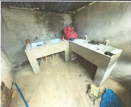
Reparación Tubería en red de drenaje sanitario para Lavamanos mas caja de registro módulo 2.
