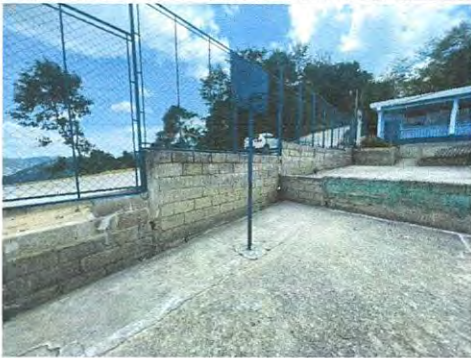
Suministro y aplicación pintura Exterior latex celeste paritone 293 para muro perimetral módulo 1 y 2.
