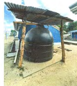
Sustitución base de madera por base de costanera de 2"X6" mas pedestal de concreto para techo de tinaco módulo 2.
