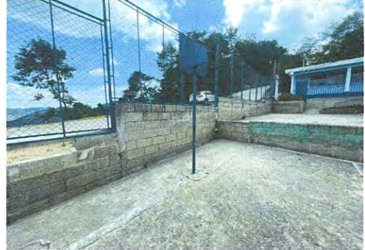
Repello en muro perimetral, area de lavamanos y pila modulo 1 y 2.
