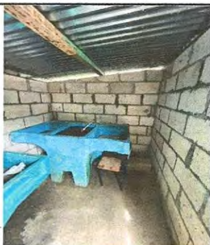
Sustitución pila de cemento por pila concreto armado mas azulejo módulo 2.
