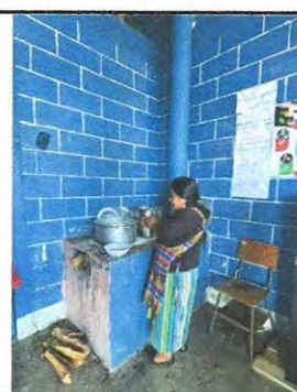
Sustitución estufa existente en cocina por estufa con azulejo mas chimenea tubo de concreto módulo 1.
