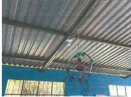
Sustitución de Bombillo LED GLOBO 30W 2400 Lúmenes en aulas módulo 1.
