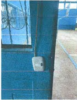
Sustitución Interruptor Simple en aulas módulo 1.
