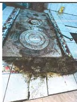
Sustitución de azulejo en estufa rural en cocina módulo 1.
