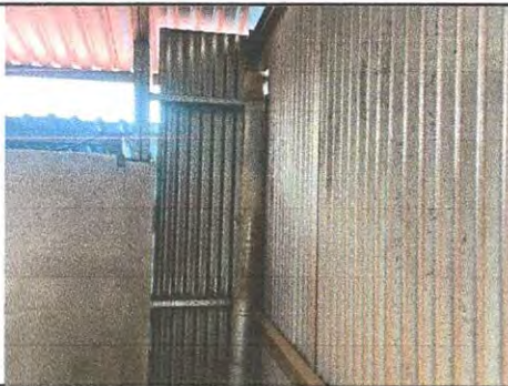
Suministro y aplicación Pintura exterior Azul Pantone 293 para pared de estructura metálica área de cocina módulo 1.
