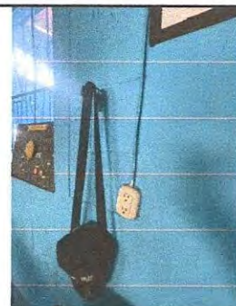
Sustitución Tomacorriente doble en aulas módulo 1.
