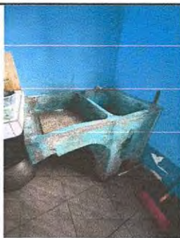
Sustitución pila de cemento por pila de cemento en cocina módulo 1.
