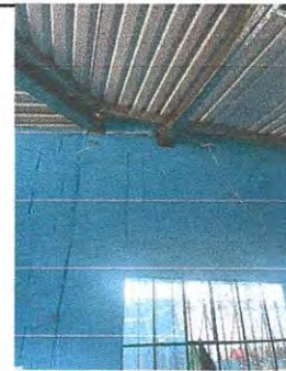
Reparación de cableado eléctrico CALIBRE 10 AWG sobre puesto en aulas módulo 1.
