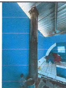
Sustitución de chimenea de concreto por chimenea de concreto en cocina módulo 1.
