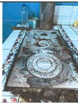
Sustitución de plancha de metal de 3 hornillas en cocina módulo 1.
