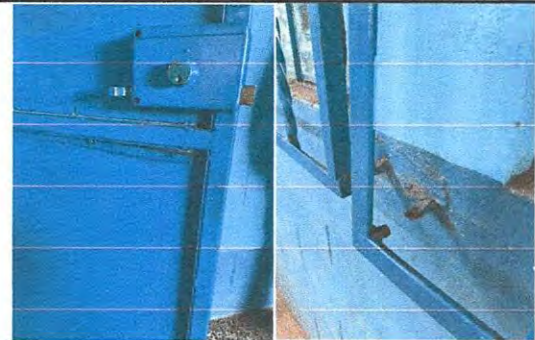
Mantenimiento correctivo de puerta y balcón en aula módulo 1.
