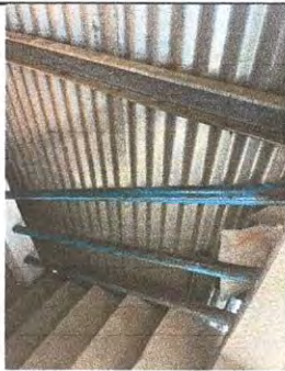
Mantenimiento a baranda de metal en gradas acceso a cocina modulo 2.
