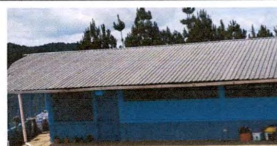
Mantenimiento preventivo de techo con limpieza y pintura en aulas de modulo 1
