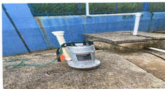
Sustitución de bomba sumergible truper en mal estado por bomba sumergible Jet inox. 1/2 24L HP TRUPER
