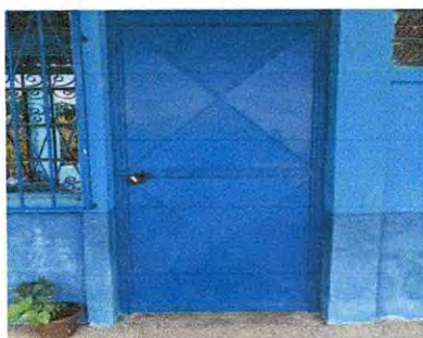
Mantenimiento de puertas de metal, lijado y pintado con pintura anticorrosiva a 2 manos en aulas de modulo 1
