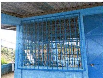
Sustitucion balcones con hierro entorchado con angular de 1 1/4 de pulgada para protección de ventanas en aulas de modulo 1
