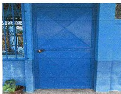
Sustitucion de chapas yale para puertas en aulas de modulo 1
