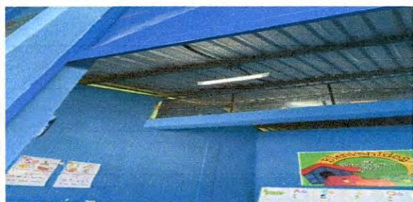
Reparación de techo con cielo falso en una aula módulo 1
