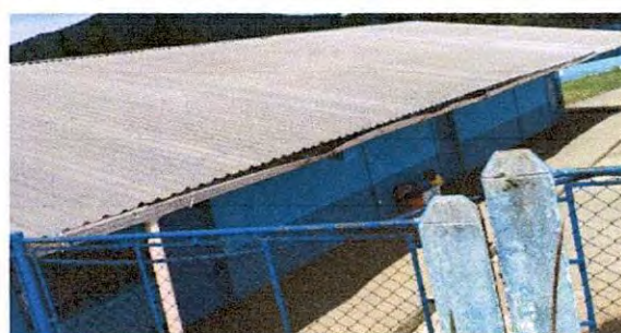
Sustitución de canal pvc por canal tipo colonial y accesorios(pescantes, tapón izquierdo y derecho, bajada pluvial y tres costaneras para sostener canal. Módulo 1
