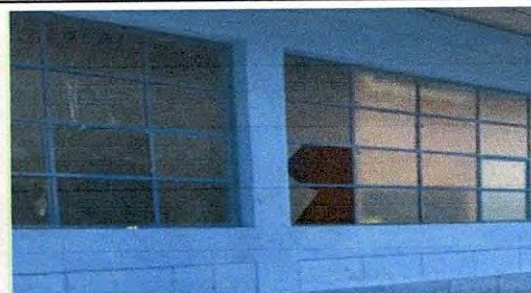
Sustitución de vidrios de 5mm en ventanas 24cm x 85cm cocina
