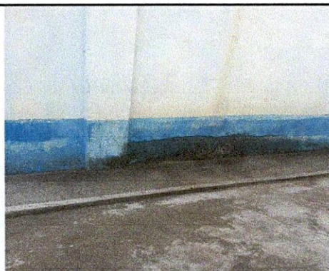
Mantenimiento de pintura del establecimiento
