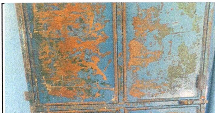
Reparación e instalación de puertas de metal
