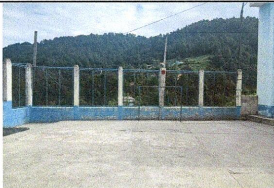
Sustitucion de circulacion de barandas de metal
